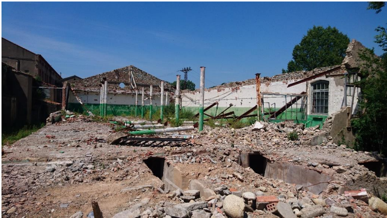
Estat previ: interior
