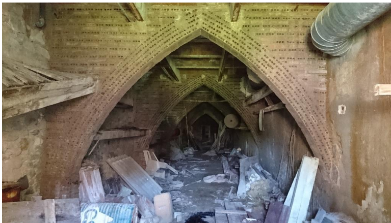
Estat previ: interior
