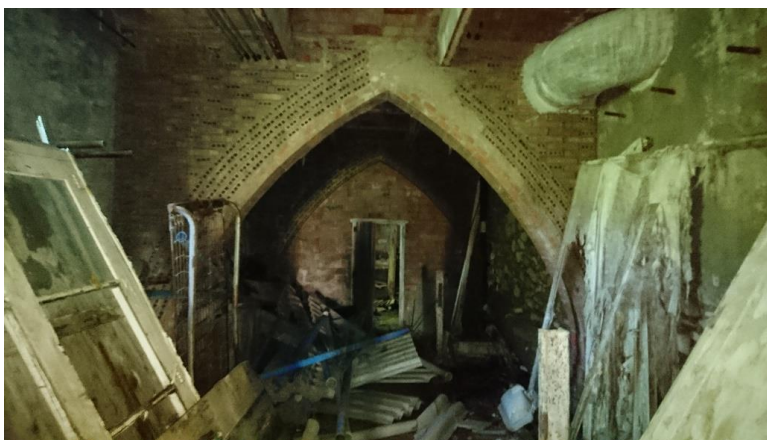
Estat previ: interior
