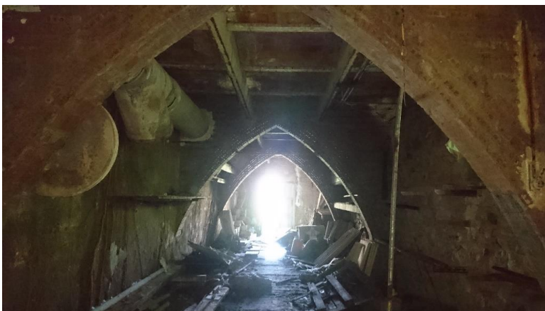
Estat previ: interior
