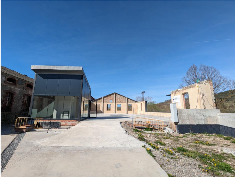
Estat actual: exterior
