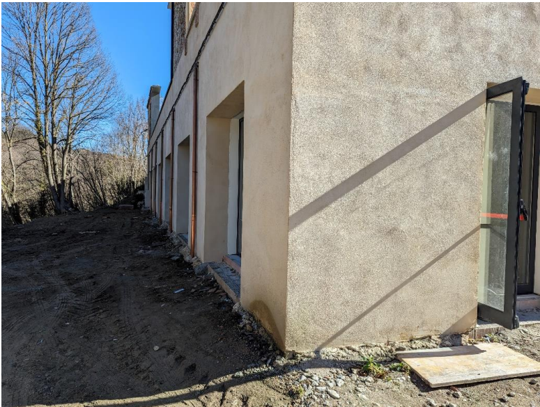
Estat actual: exterior
