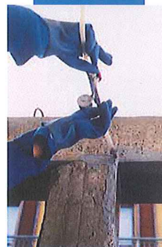
Aplacado metálico con Adesilex PG1
