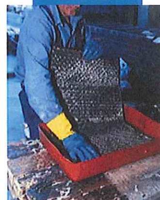
Impregnación manual de MapeWrap C
