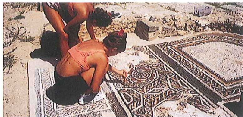
Yacimiento arqueológico: Reposición de un antiguo pavimento de mosaico con MAPE-ANTIQUE LC
