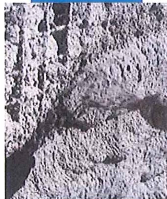
Applicazione di Mape-Antique Strutturale NHL
