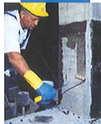
Applicazione della 1ª mano di Mapewrap Primer 1
