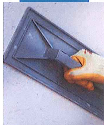
Ripianatura dell'intonaco
