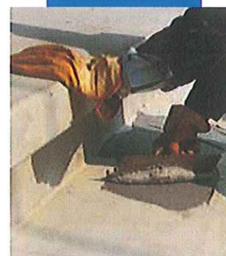
Extendido de Adesilex PG1 con llana dentada para el encolado de peldaños prefabricados
