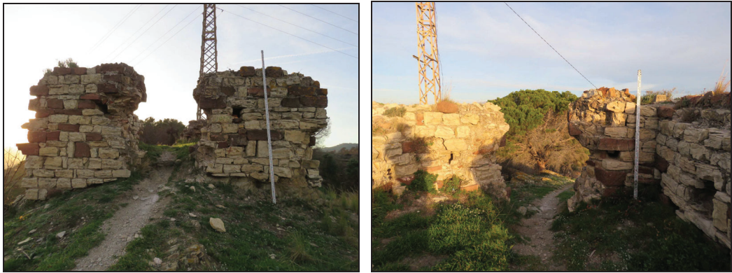
Vista exterior i interior de MR-2
