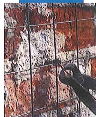
Fissaggio di rete zincata alla muratura
