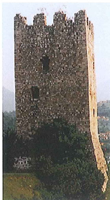
Torre de S. Floriano consolidada con inyección de MAPE-ANTIQUE I
