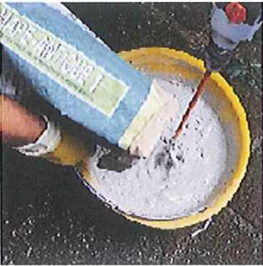
Preparación de la mezcla de MAPE-ANTIQUE I
