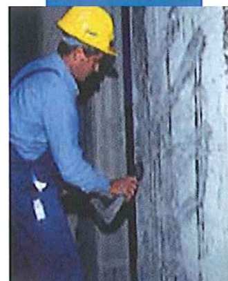
Preparazione del supporto
