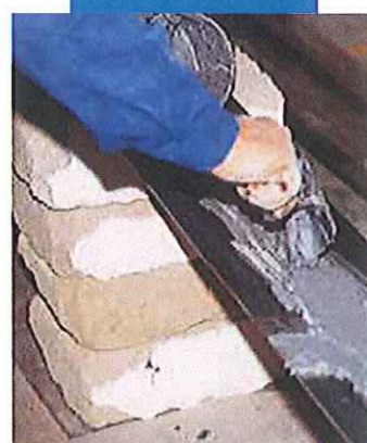
Extendido de Adesilex PG1 sobre una pletina metálica
