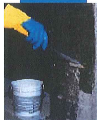
Applicazione della 2ª mano di Mapewrap Primer 1
