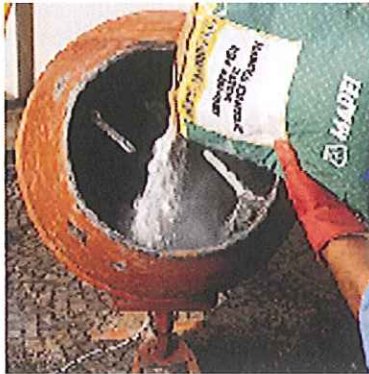
Preparación de la mezcla de MAPE-ANTIQUE LC
