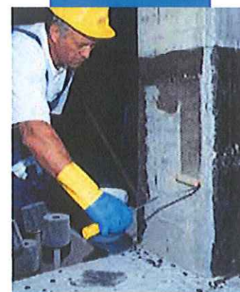
Aplicación de MapeWrap Primer 1
