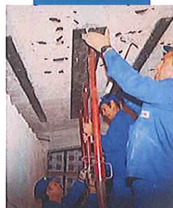
Puesta en obra de una pletina metálica como refuerzo estructural
