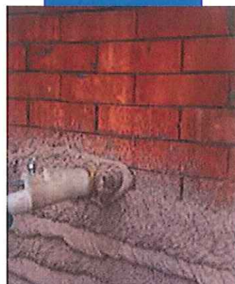
Applicazione a spruzzo di Planitop HDM Restauro su parete in muratura
