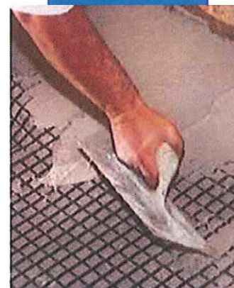
Posa del secondo strato a spatola di Planitop HDM Restauro all'estradosso di una volta in modo da coprire in maniera omogenea la rete Mapegrid G 220
