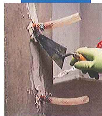
Fijación de la boquilla de inyección y sellado de la fisura antes de proceder a la consolidación estructural
