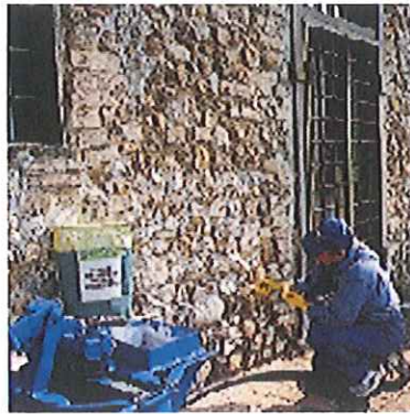
Inyección de consolidación con MAPE-ANTIQUE I
