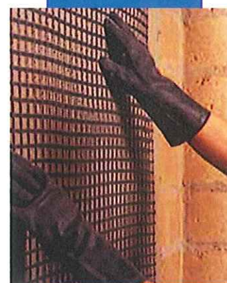
Colocación de Mapegrid G 220
