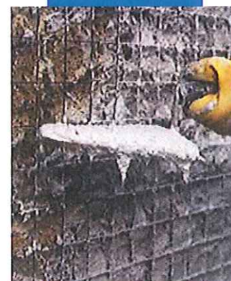
Applicazione di Mape-Antique Rinzaffo su muratura meccanicamente debole
