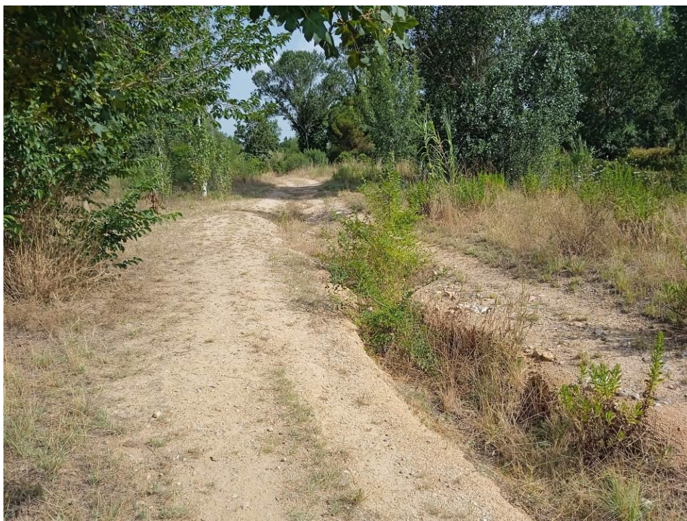
Fotografia 6. Esvoranc en camí existent situat a l'oest de l'àmbit. Es preveu el condicionament de la plataforma del camí.
