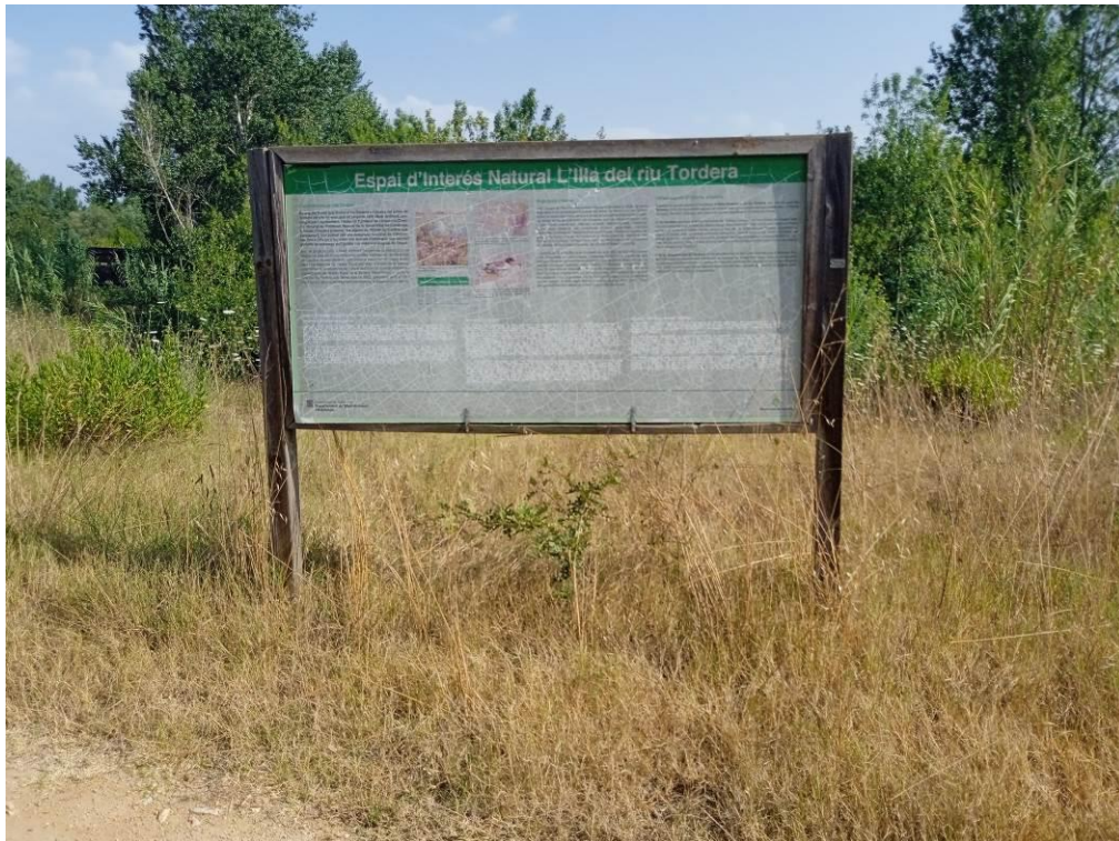
Fotografia 12. Plafó informatiu actual deteriorat, vista frontal.
