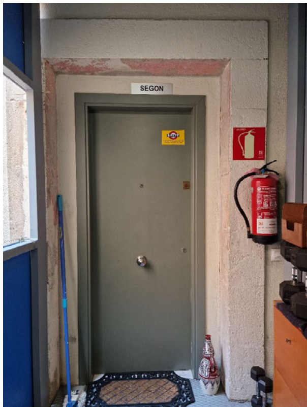
P2- Façana interior – accés habitatge des d'ascensor
