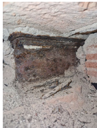
PB- Detall dintell façana interior
