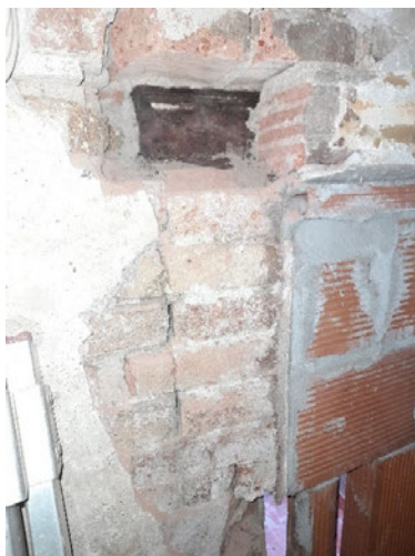
PB- Dintell façana interior
