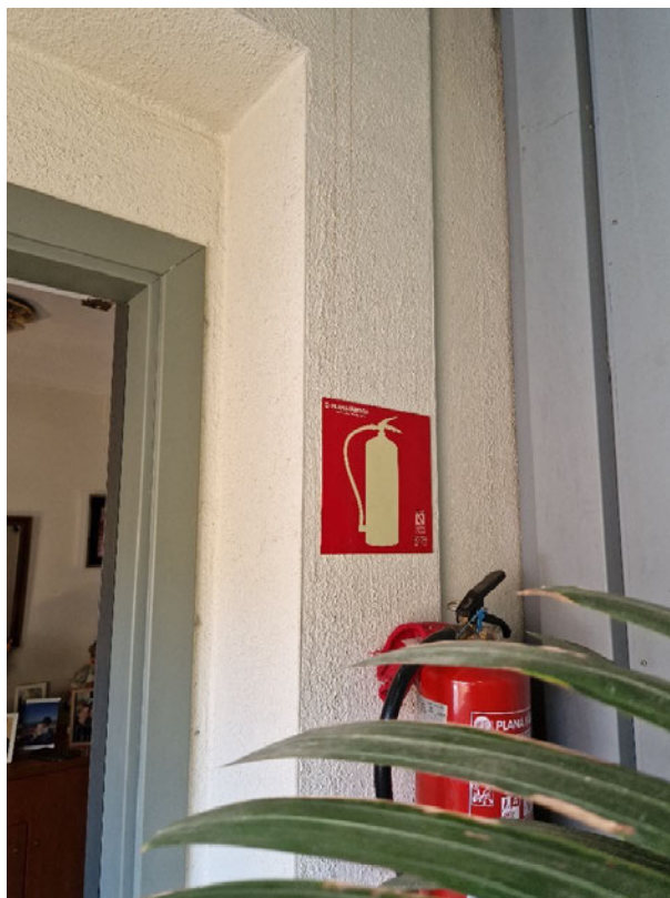
P4- Façana interior – detall de façana
