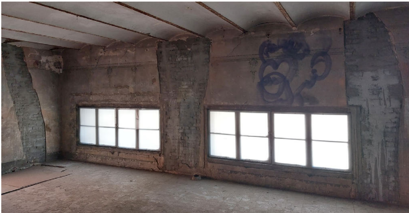
PA- Parament interior de façana C/ Comerç
