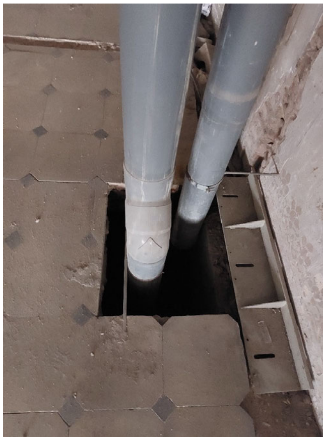
Paviment existent - TIPUS 3
