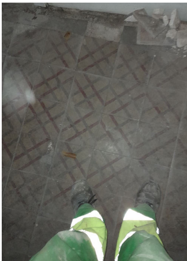
Paviment existent - TIPUS 2
