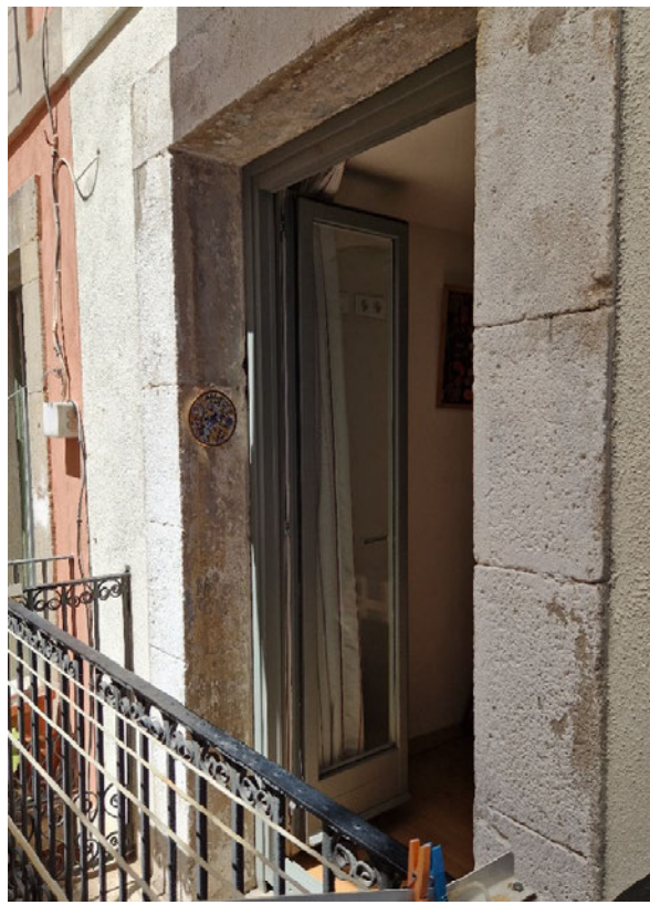
Fusteries pati interior (Noves de la Reforma 2009, igual que a P4)
