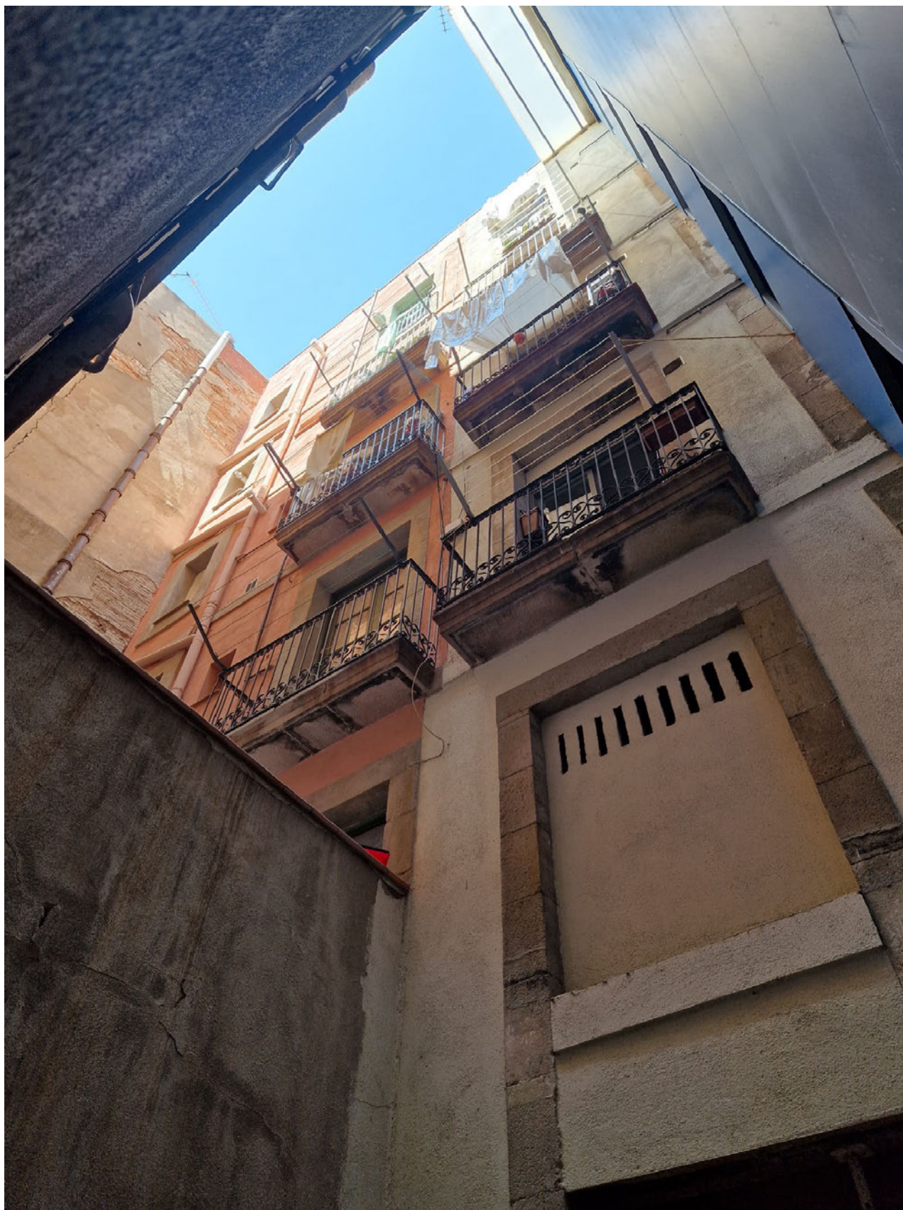
Façana interior - acabat
