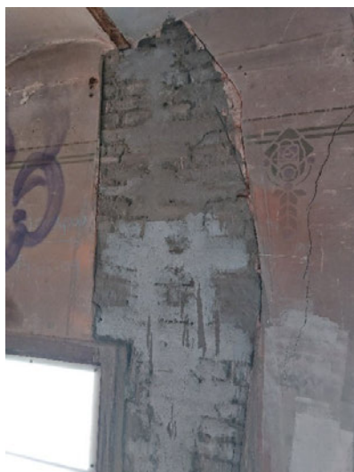
PA- Detall cosit d'esquerdes
