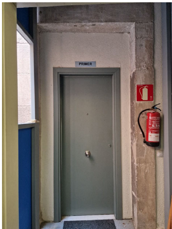
P1- Façana interior – accés habitatge des d'ascensor
