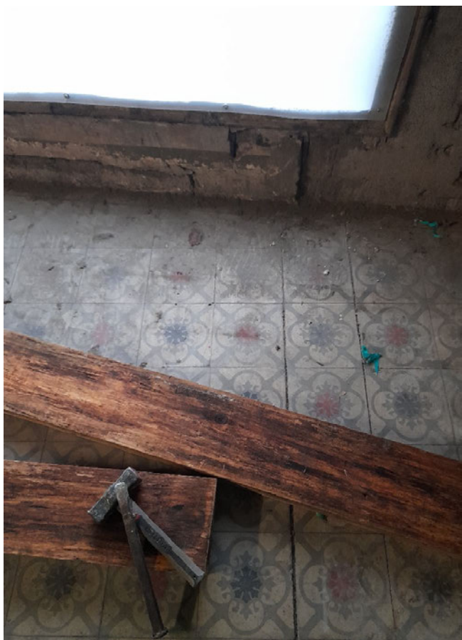
Paviment existent - TIPUS 1
