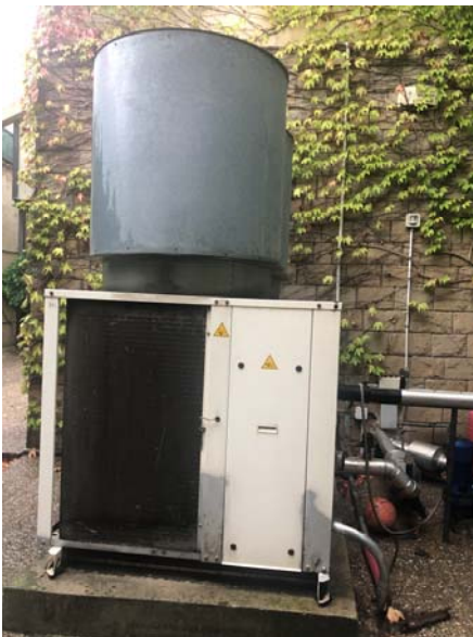
Desmuntatge i substitució de refredadora/bomba de calor Edifici La Rectoria.
