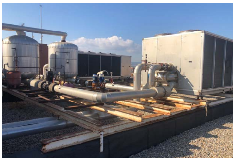
Desmuntatge i renovació de refredadora/bomba de calor Edifici Centre Cultural Garcia Nieto
