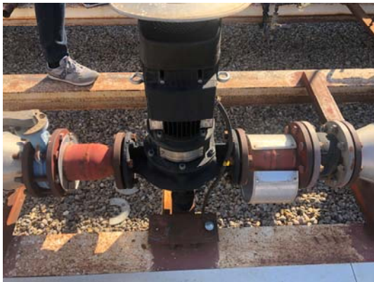
Desmuntatge i renovació de bombes de circulació Edifici Centre Cultural Garcia Nieto
