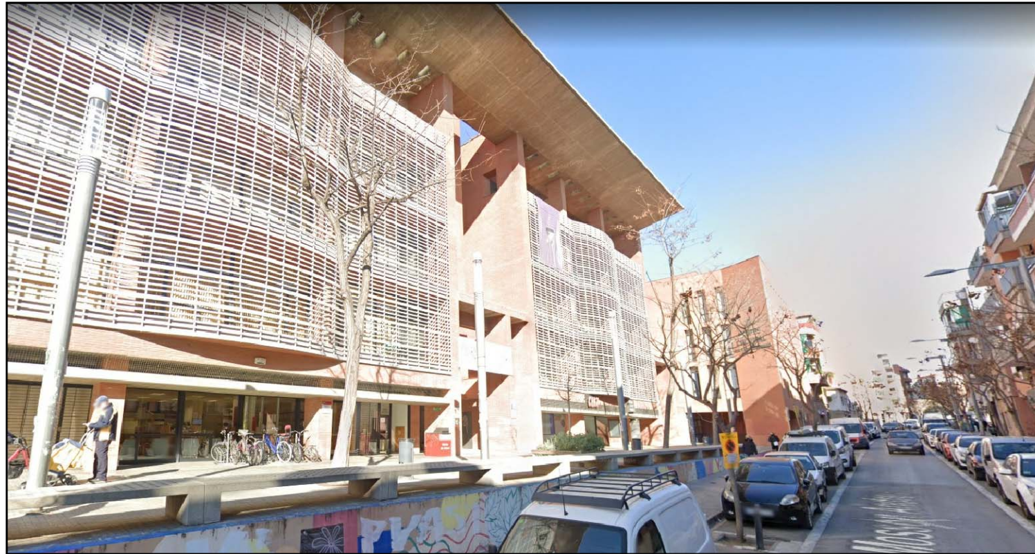
FOTOGRAFIA FAÇANA CENTRE CULTURAL J.G.NIETO
