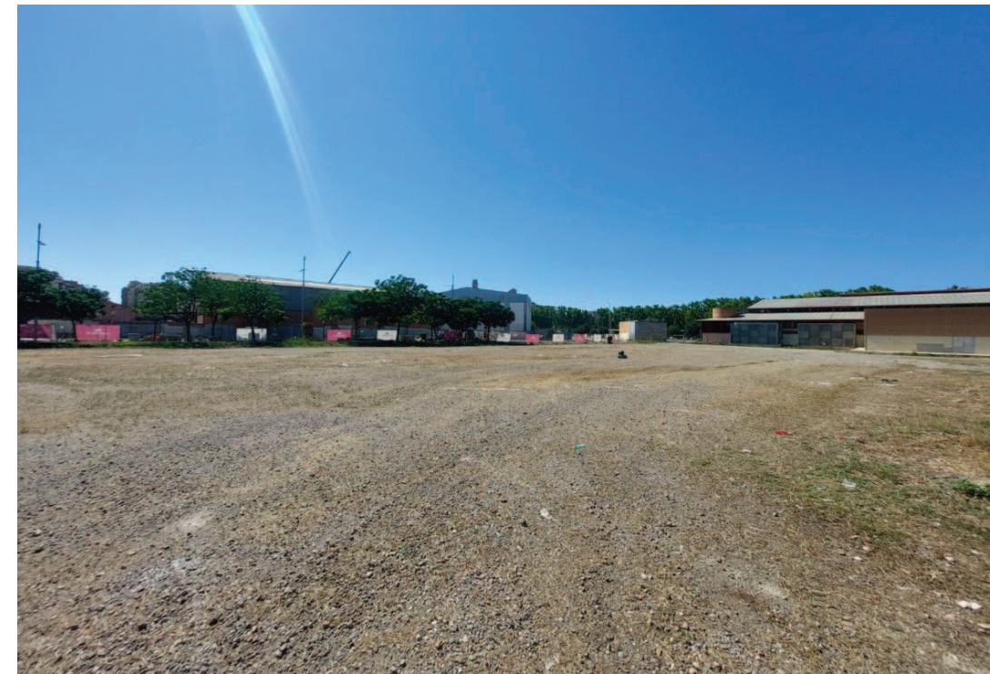
Fotografia de l'àrea prevista del projecte de construcció d'un nou Pavelló en l'espai Firal de Lleida.
