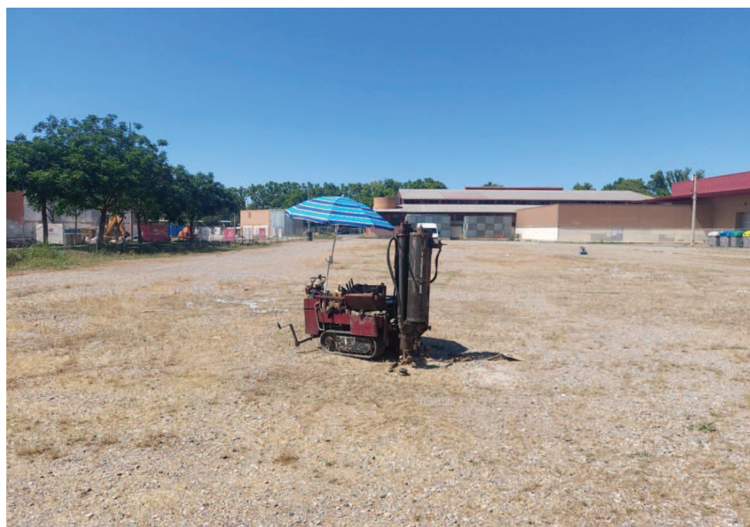
Fotografies de l'emplaçament de l'assaig PD-3 en l'àrea de la planta prevista.
