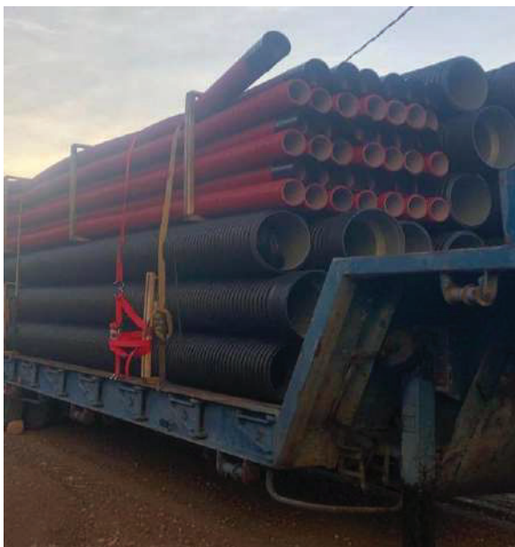
Tub de PE autoportant de 315 i tub rigid de 125
