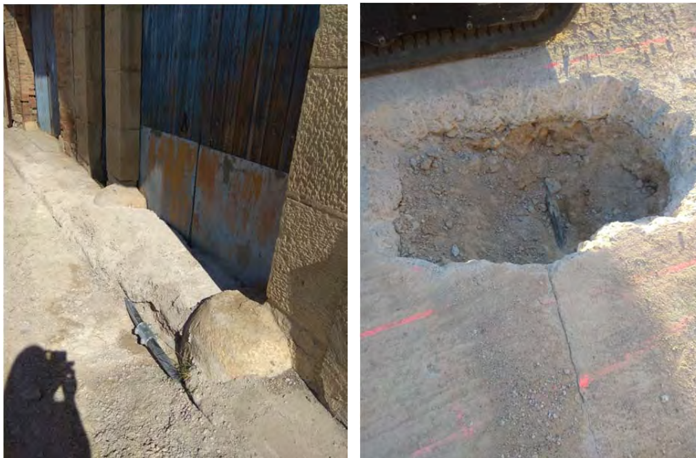
Imatges descriptives de la fondària de la canonada
