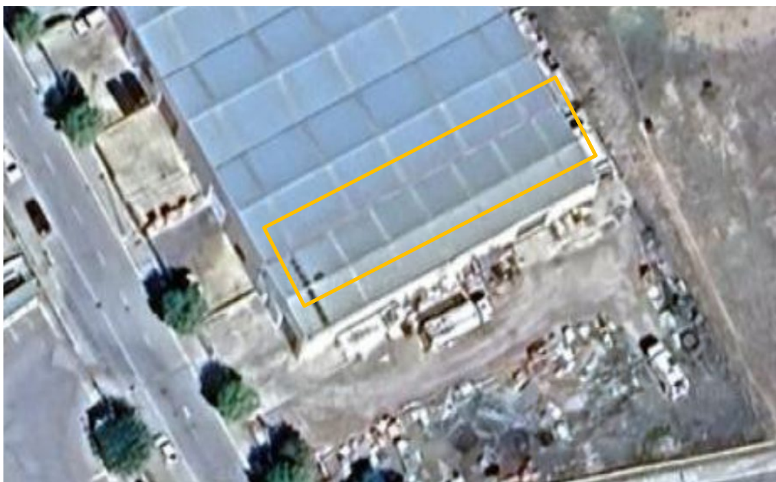
Imatge 1: Imatge de la ubicació on es realitzarà la instal·lació.
