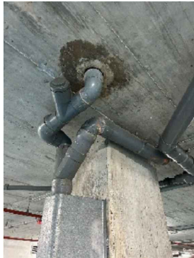
61- 2U colze baixant Ø125mm
