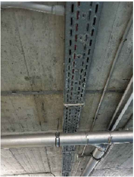
53- 1U safata metàl·lica 20x10cm L=300cm, 1U lluminària pantalla L=120cm, 2U tub metàl·lic elèctric Ø20/40, L=300cm
