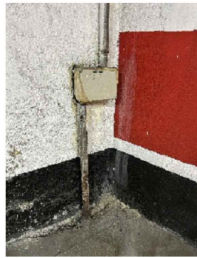
37- 1U tub metàl·lic elèctric de Ø20/40, L=100cm, 1U tub metàl·lic elèctric de Ø20/40, L=300cm, 1U caixa metàl·lica de connexió de 30X20cm
