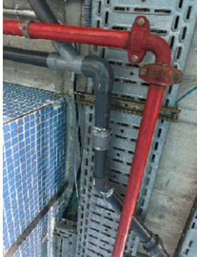
59- 1U canonada ruixador Ø1-1/2", L=300cm, 1U colze Ø1-1/2"
