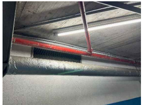
66- 1U canonada ruixador Ø4", L=400cm, 1U canonada ruixador Ø2-1/2", L=400cm
