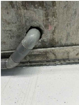
27- 1U colze baixant Ø125mm
