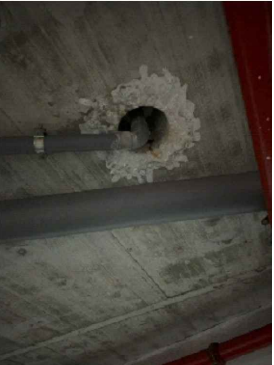
87- 1U Colze baixant Ø75mm
