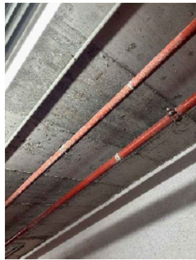
38- 1U canonada BIE, Ø2-1/2", L=400cm, 1U canonada ruixador, Ø1-1/2", L=400cm
