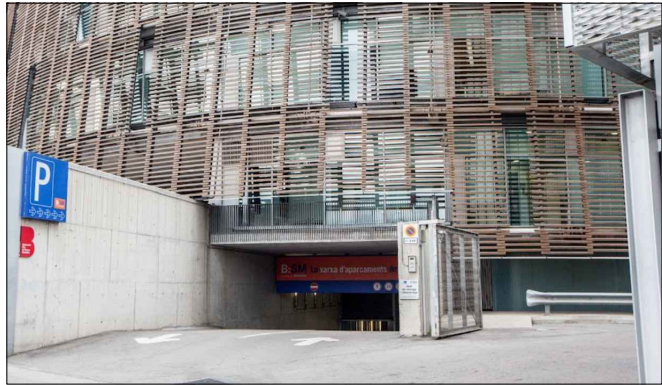
Imatge entrada aparcament per C/ del Dr. Aiguader
