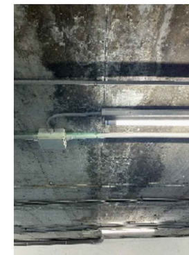
27- 8U tubs metàl·lics elèctrics Ø20/40, L=300cm, 2U lluminàries pantalla L=120cm
