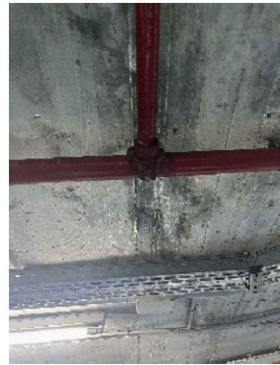
05- 1U canonada bie. Ø2-1/2", L=300cm, 1U canonada ruixador. Ø3", L=300cm
