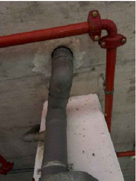
71- 1U colze baixant Ø125mm
