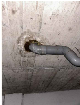
32- 1U colze baixant Ø125mm
