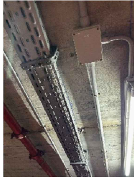
47- 1U safata metàl·lica de 20X10cm I L=300cm, 2U tub metàl·lic elèctric de Ø20/40, L=300cm, 1U lluminària pantalla L=120cm
