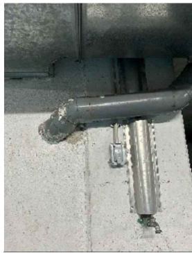
69- 1U colze baixant Ø125mm, 2U tram de baixant, Ø125mm L=100cm
