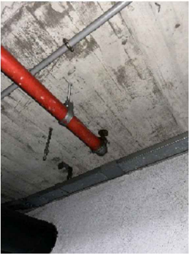
15- 1U canonada ruixador Ø1-1/2", L=400cm, 1U ruixador, 1U unió Ø2-1/2 amb Ø1-1/2"
