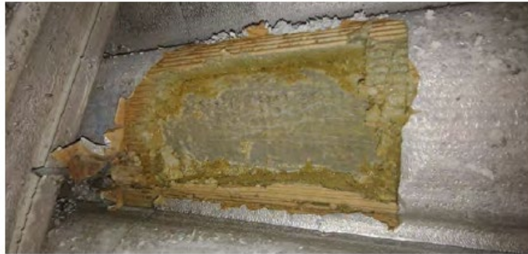
Cala a la cara inferior d'una placa ondulada de coberta per comprovar gruix d'aïllament
