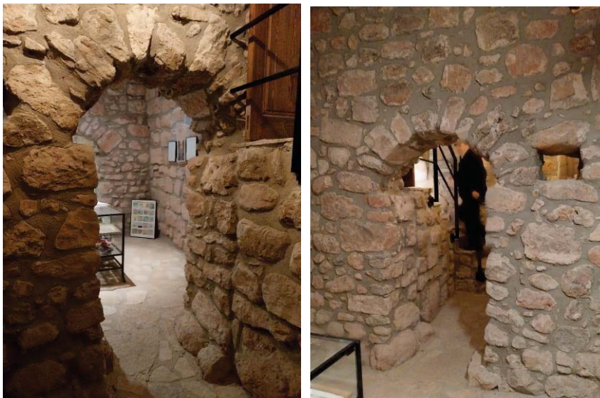
Vista de l'espai de la cripta rejuntat.
