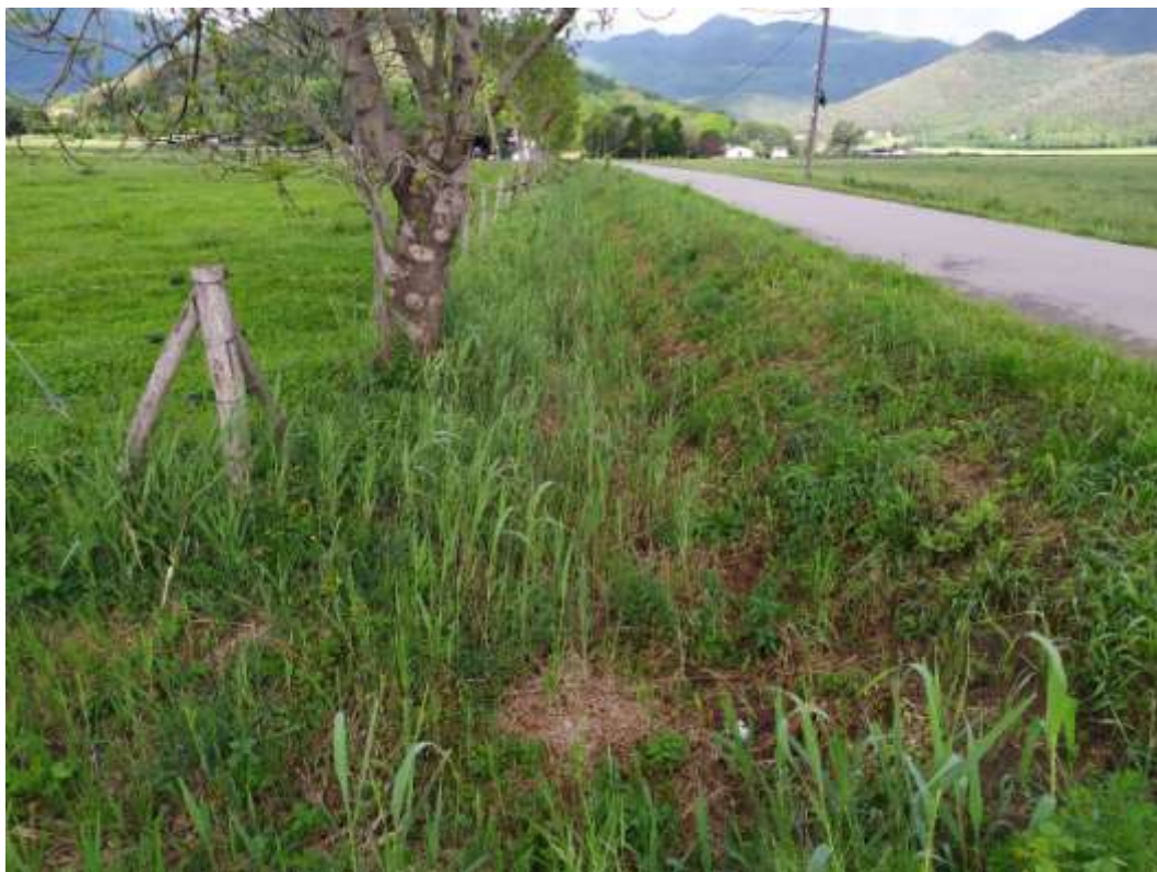
Foto 8: Enllaç del drenatge longitudinal del camí costat est. Amb el reg que enllaça amb el Torrent de Tirafaves
