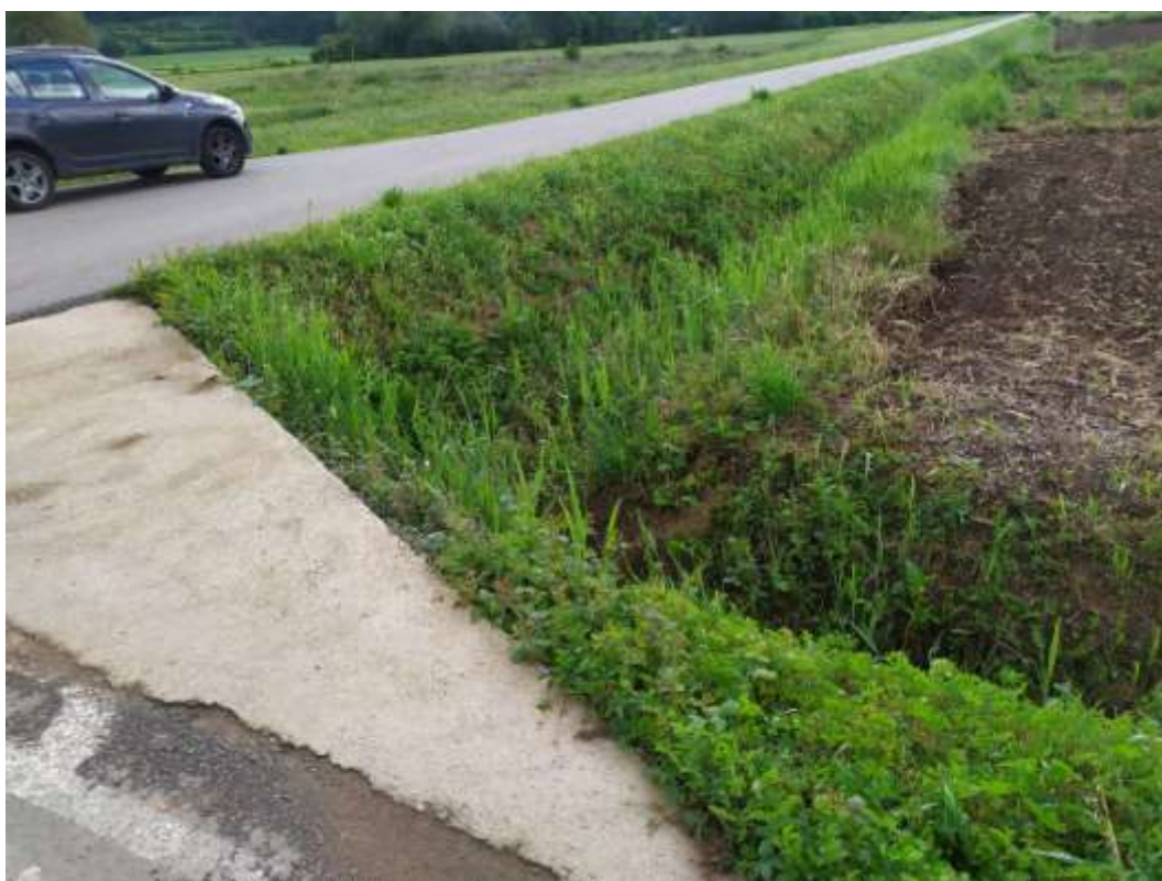
Foto 6: Enllaç drenatge longitudinal camí costat est. Amb el reg que enllaça amb el Torrent de Tirafaves
