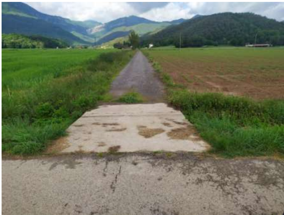
Figura 4. Imatge del camí d'accés provisional des de Can Benet del Pla.
