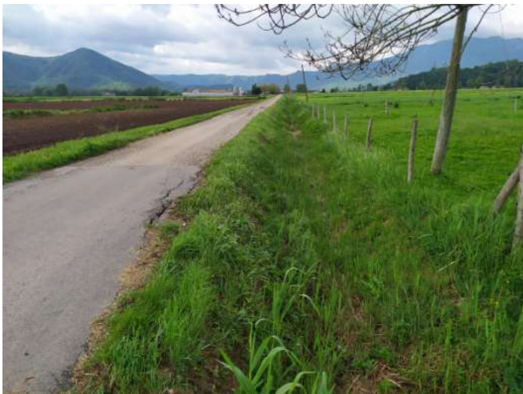
Foto 7: Drenatge longitudinal del camí de Can Ramonic costat oest. Aigües amunt de l'obra de drenatge del camí.
