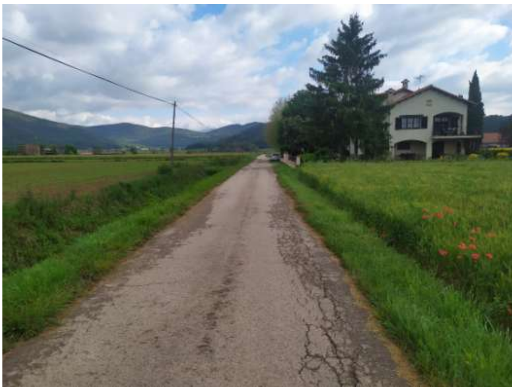
Foto 9: PK 0+370 a PK 0+488,54 Camí d'accés provisional durant les obres..
