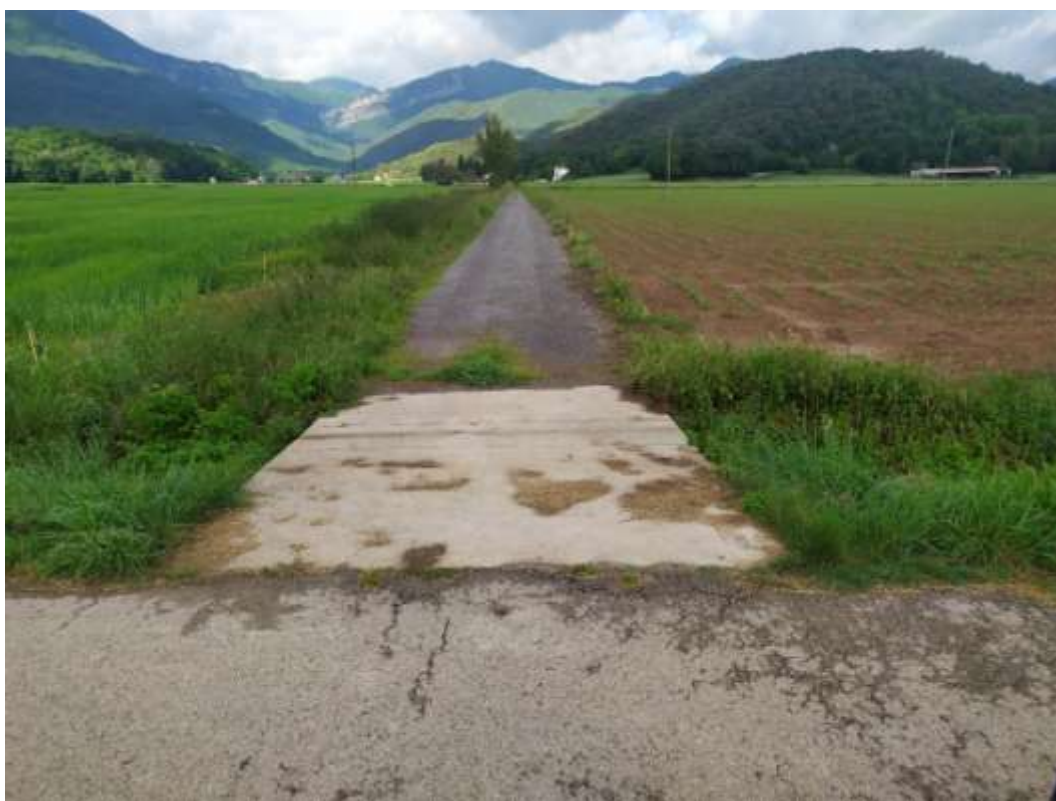
Foto 10: Inici camí d'accés provisional durant les obres. Detall d'obra de drenatge a ampliar per el gir dels camions
