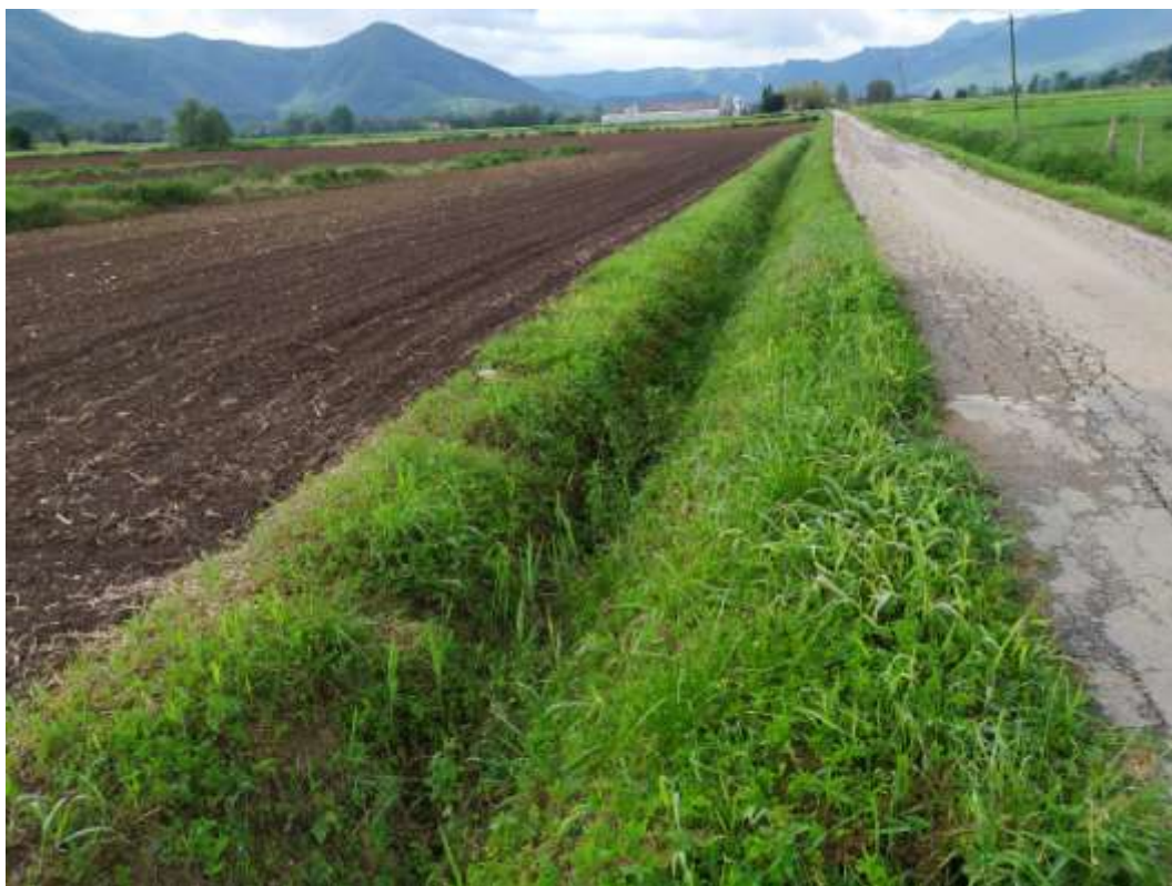
Foto 5: Drenatge longitudinal del camí de Can Ramonic costat est. Aigües avall de l'obra de drenatge del camí
