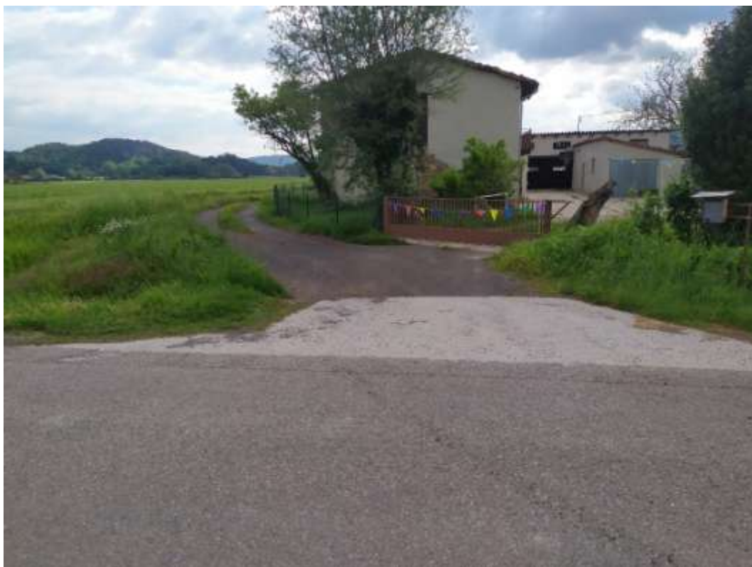
Foto 11: Fi del camí d'accés provisional durant les obres. Detall d'obra de drenatge a ampliar per el gir dels camions a Can Benet del Pla.
