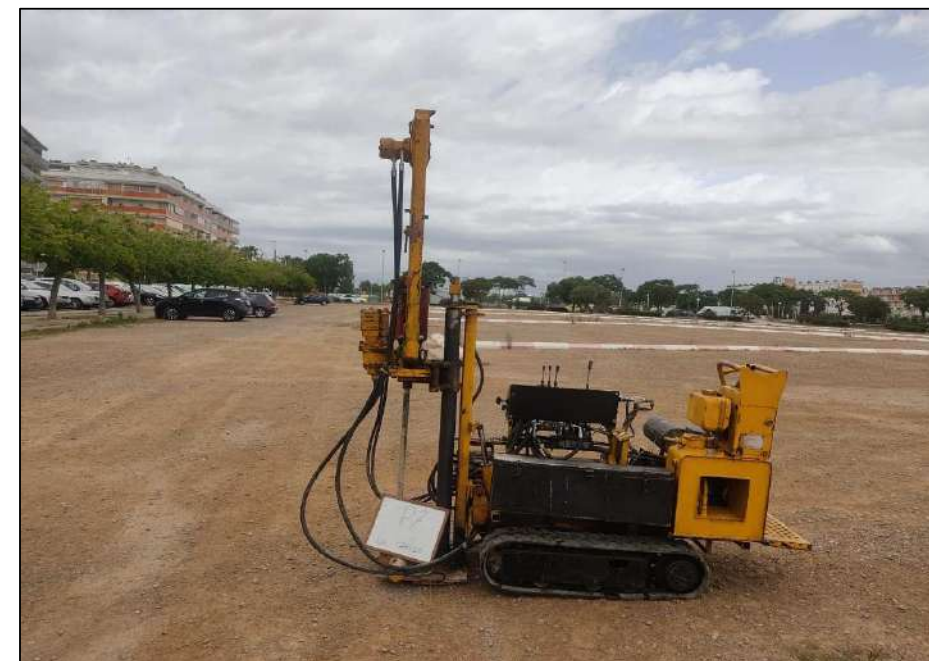
Emplaçament del penetròmetre P-7.
