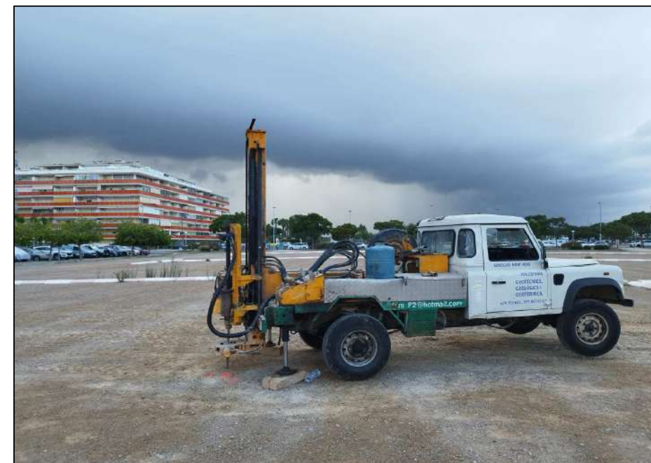
Emplaçament del penetròmetre P-6.
