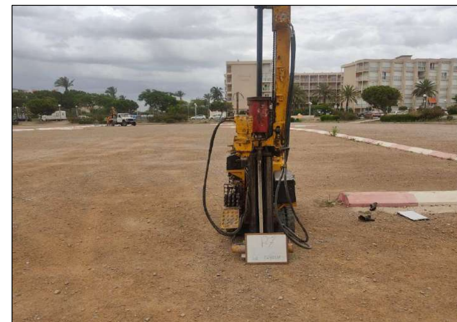
Emplaçament del penetròmetre P-7.
