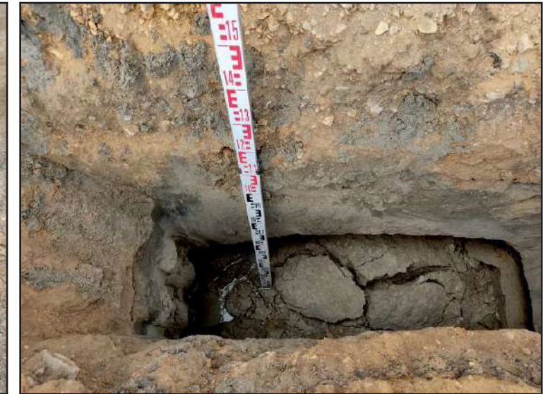
Vista del fons de la cala C-4.
