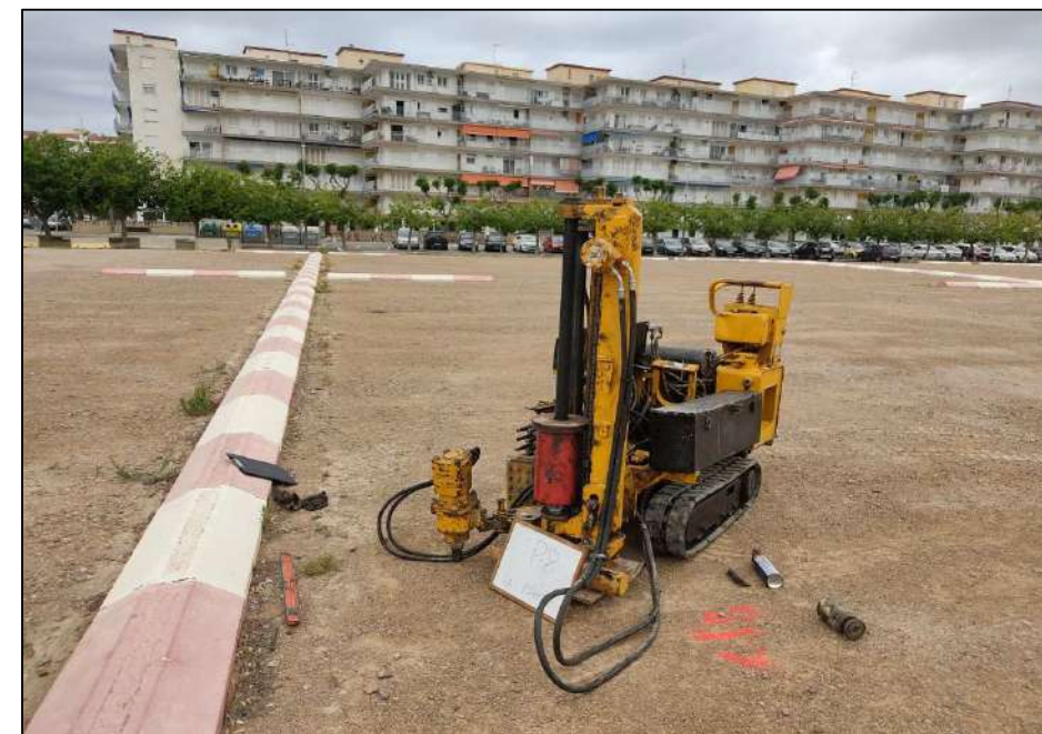
Emplaçament del penetròmetre P-8.
