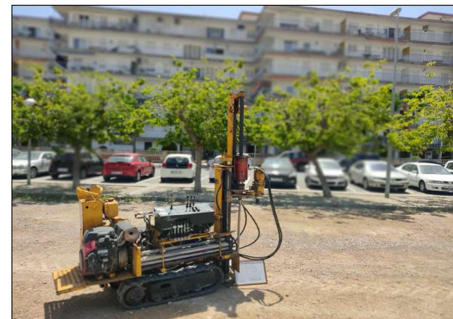
Emplaçament del penetròmetre P-5.
