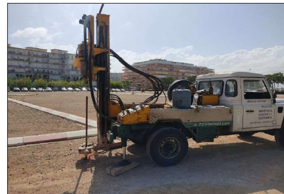
Emplaçament del penetròmetre P-1.
