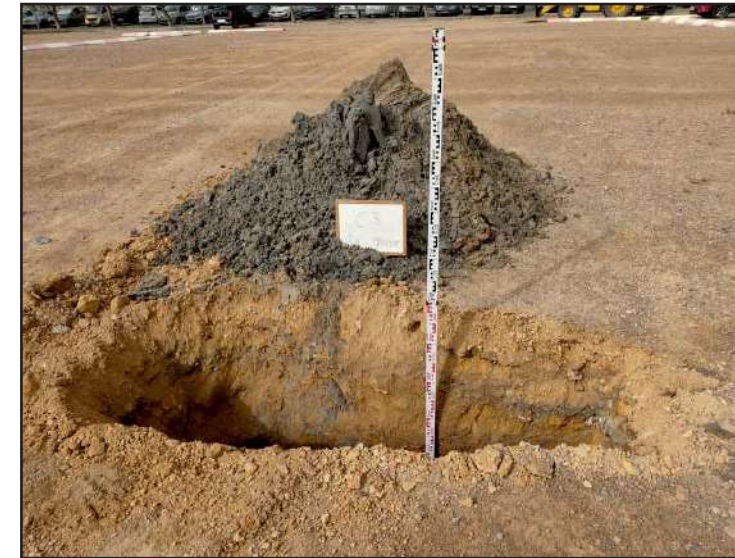
Vista general de la cala C-3.
