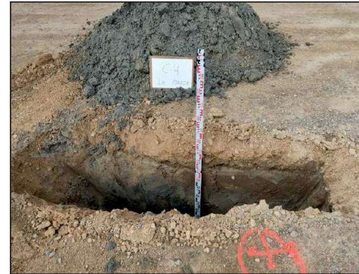
Vista general de la cala C-4.
