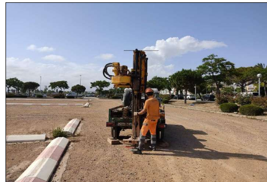
Emplaçament del penetròmetre P-1.
