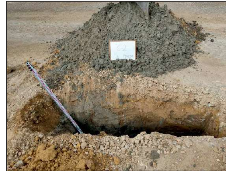
Vista general de la cala C-2.
