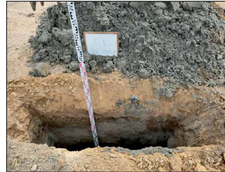
Vista general de la cala C-1.
