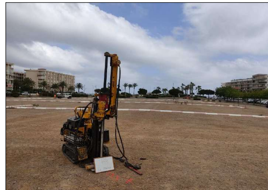
Emplaçament del penetròmetre P-3.
