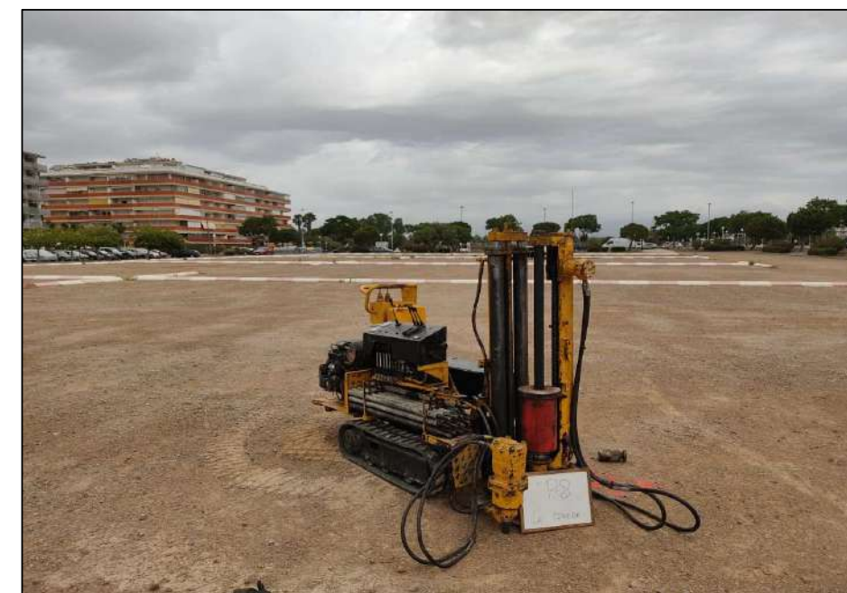
Emplaçament del penetròmetre P-8.
