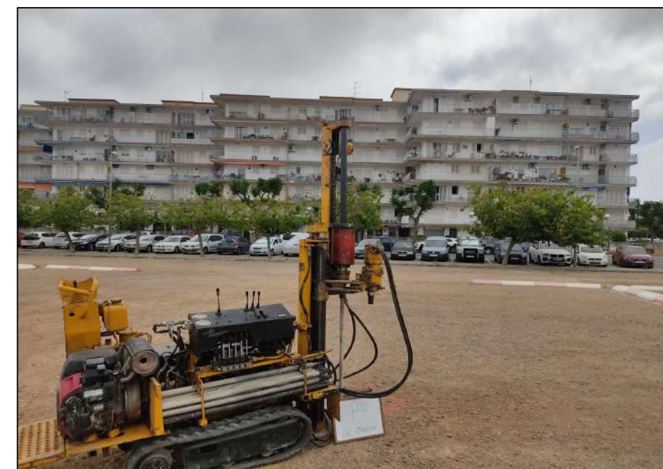
Emplaçament del penetròmetre P-3.
