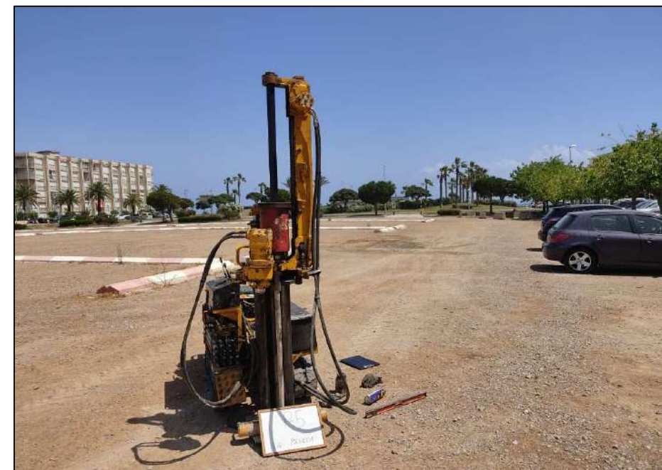
Emplaçament del penetròmetre P-5.
