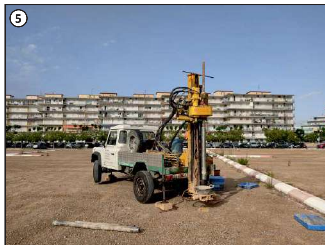
Vista desdel lateral nord-est amb l'emplaçament del punt de sondeig S-1 i C/ Victòria dels Àngels al fons.
