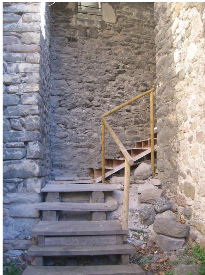
V1. REPLÀ I GIR ESCALA DE FUSTA Font: GAA 2009
