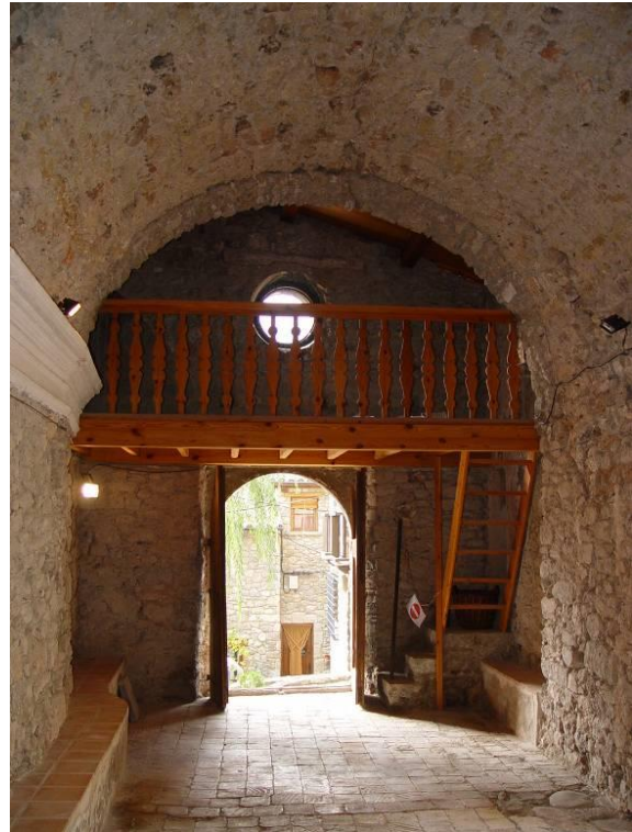
Cor i òcul a façana de migdia, accés principal (2008)
