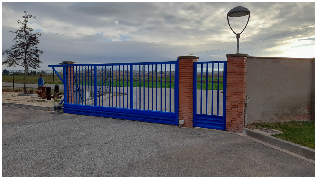
Estat actual accés EDAR
