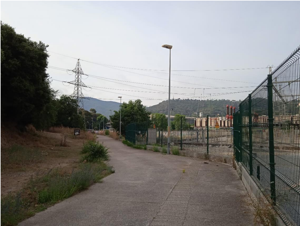
Il·lustració 1: Camí est que permet l'accés a la zona anterior del terreny, per l'exterior. Adjacent al perímetre de l'estació transformadora.
