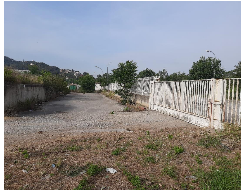
Il·lustració 6: Zona d'accés a l'emplaçament, apta per a vehicles rodats. Perímetre previst per a la zona de servitud de 10m.
