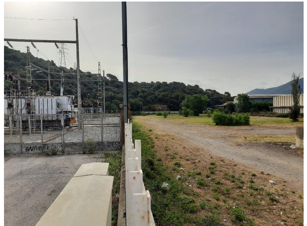
Il·lustració 4: Zona límit de la parcel·la, contigua a l'estació transformadora. Zona est de l'emplaçament os es preveu pas de 5m per a circulació.
