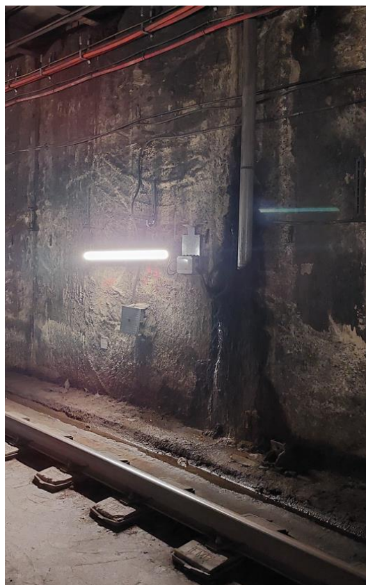
Imatge 17. Tub sense completar PK110+912
