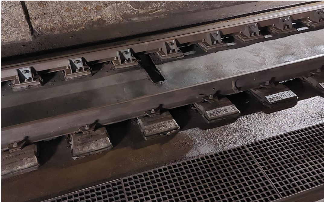
Imatge 15. Exemple drenatge transversal a obrir
