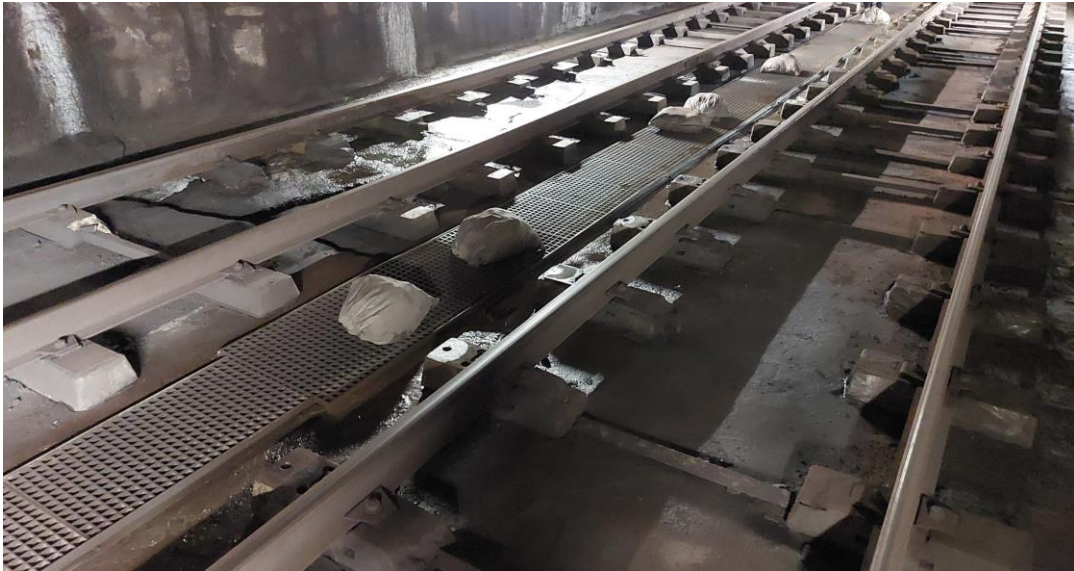
Imatge 7. Fotografia estat via tram PK 110+565 a 110+520.
