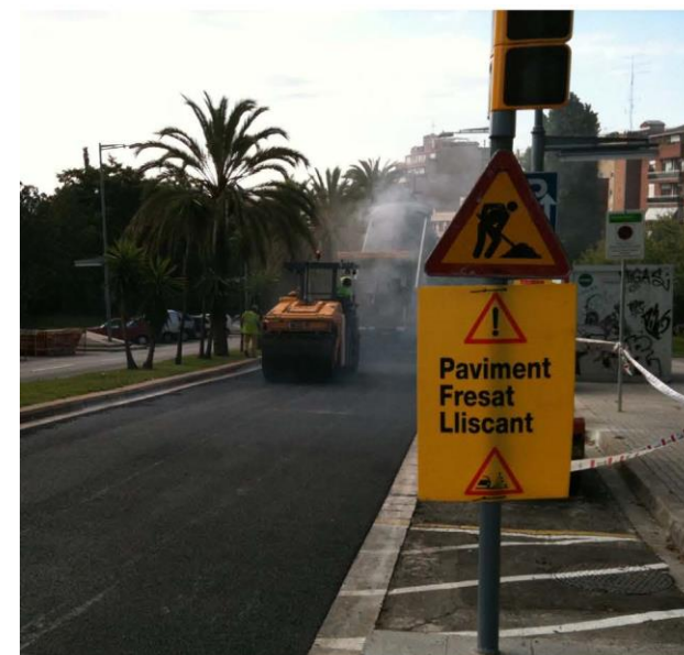
Ejemplo: Asfalto en frío en paso de peatones señalizado con banda amarilla y delimitación acera durante fresado.
