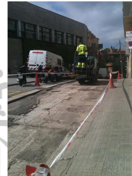
Ejemplo: Asfalto en frío en paso de peatones señalizado con banda amarilla y delimitación acera durante fresado.
