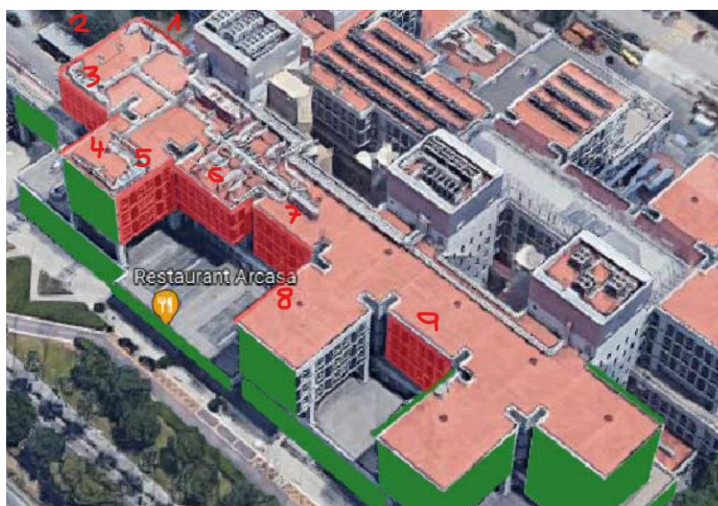
Figura 3.1. Imatge general de l'edifici amb les 9 façanes on es preveu actuar
