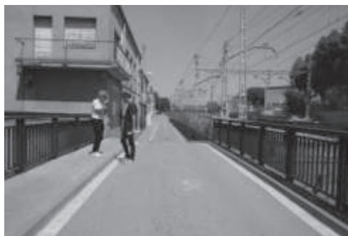
Imatge 3: Vista superior del pont des del Carrer Estació.
