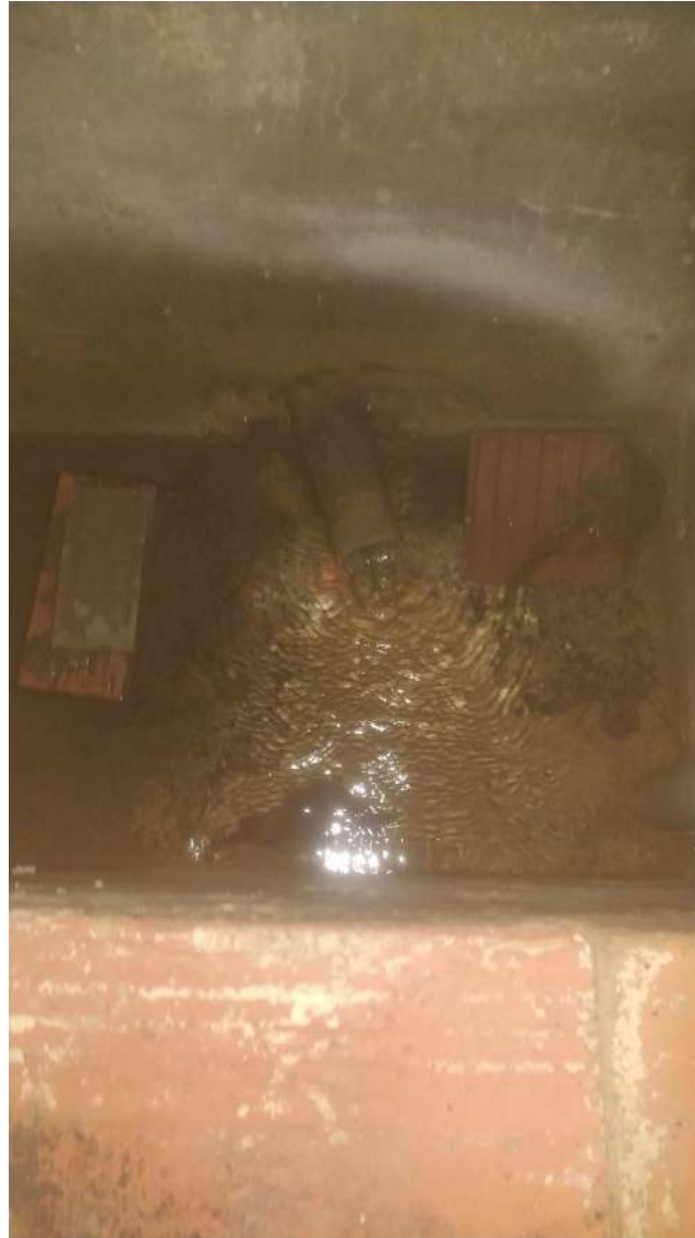
PUNT FINAL CANONADA A SUBSTITUIR EN CONNEXIÓ AL DIPÒSIT MUNICIPAL
