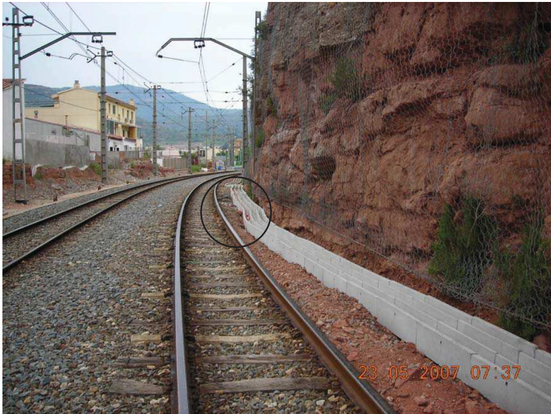
Figura 3.8 Exemple de superposició de canalització sobre banqueteta de la via
