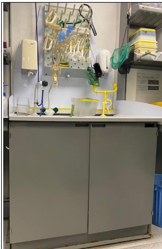
Imatge 1 Mòdul d'aigüera amb portes i escorredor
