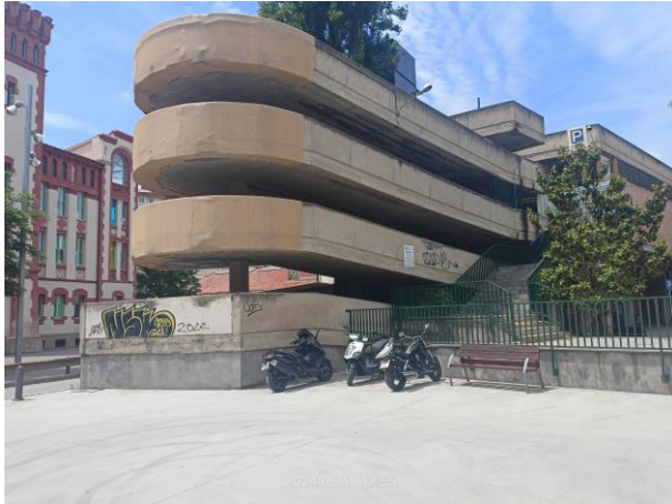
Rampa peatonal C/del Bisbe Morgades
