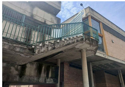
barana existent metal·lica
