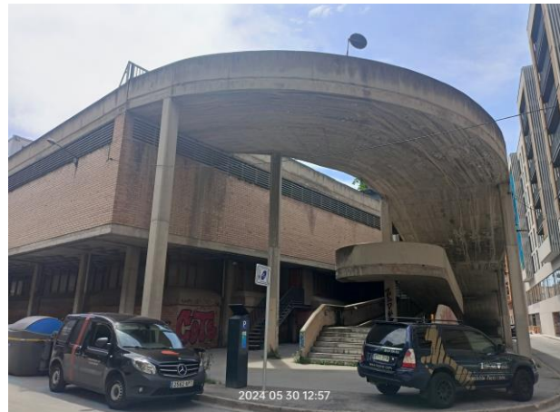
Rampa vehicles C/dels Morató
