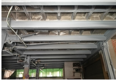
reforç estructural bigues metàl·liques existent
