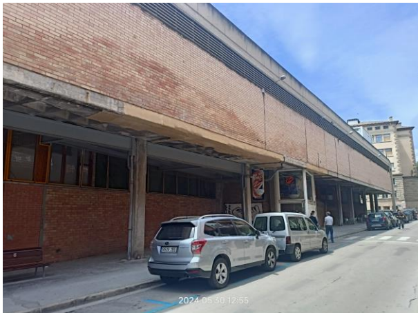
Façana nord C/dels Morató
