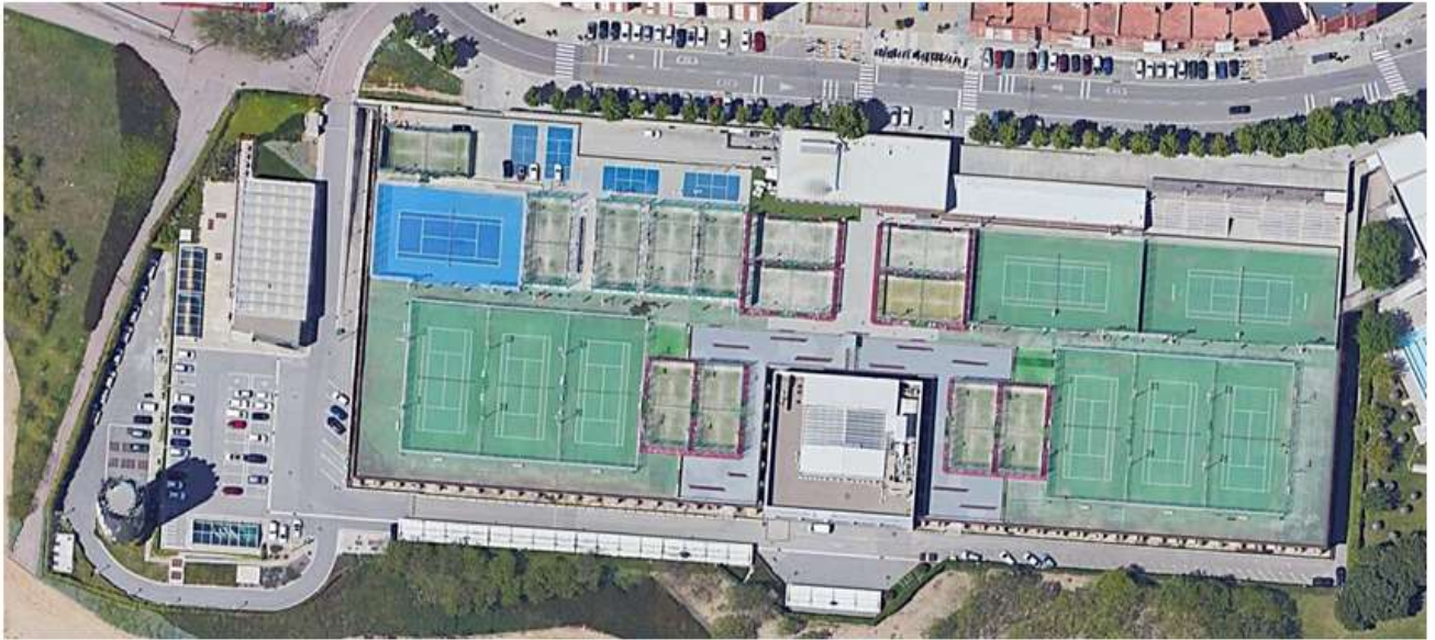
Foto: Instal·lacions dipòsits de La Font Santa
