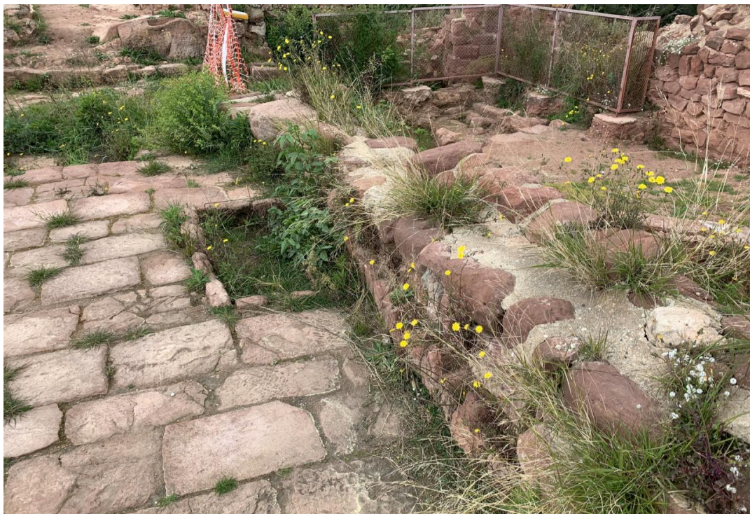
Vista de la xemeneia i mur central de la Sala. Font: R. Guitart.
