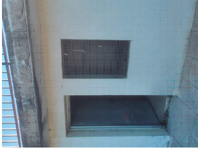
ESTAT ACTUAL - ENTRADA VESTIDOR 3
