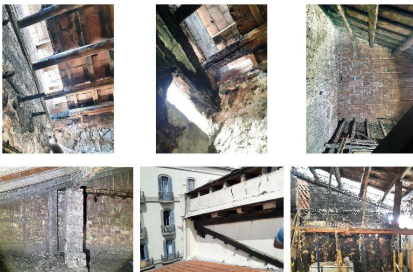
Imatges de l'estat actual
