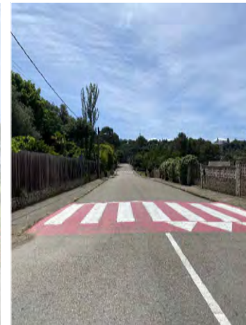
V13. c/Pica d'Estats. Línia d'alta tensió. Font: GAA (04/07/2024)
