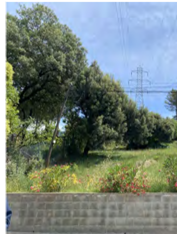
V12. c/Pica d'Estats. Línia d'alta tensió. Font: GAA (04/07/2024)
