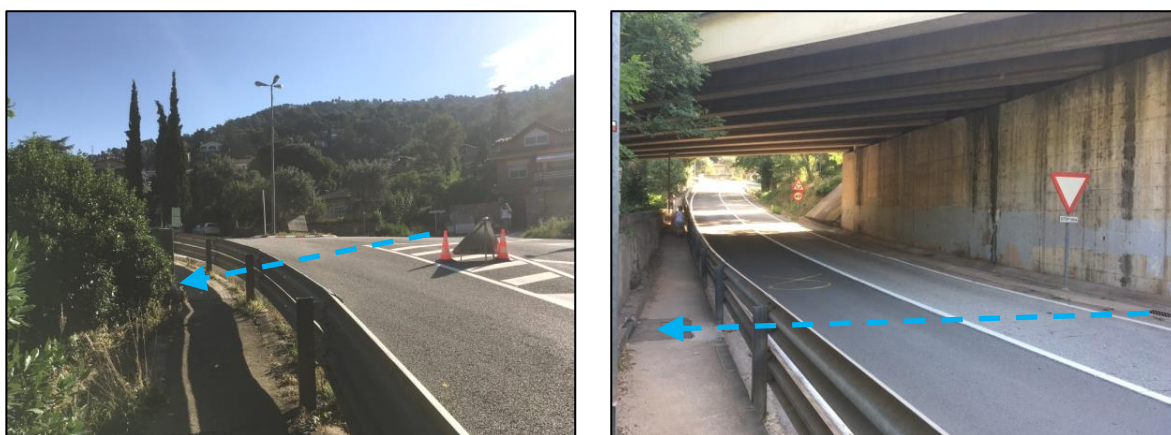
Figura 5. Obres de drenatge als PK 0+022 i 0+128
