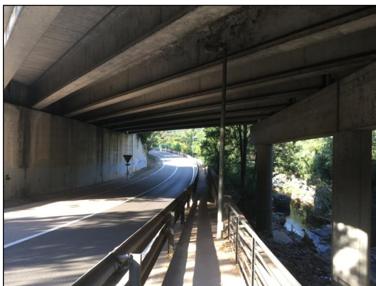
FOTO 14. Pas inferior de l'autovia C-17
