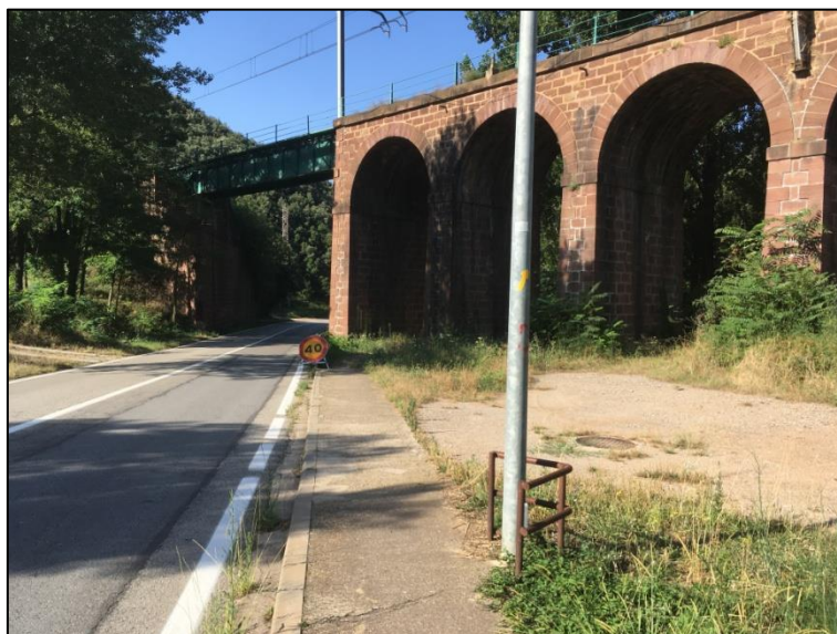
FOTO 44. Pas inferior de la línia de ferrocarril de rodalies R3
