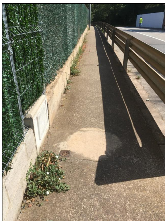
FOTO 39. Tapa de registre d'una escomesa d'aigua
