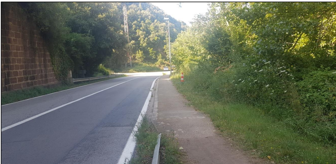
FOTO 57. Punt on el paviment del carril bici i de vianants torna a ser de formigó
