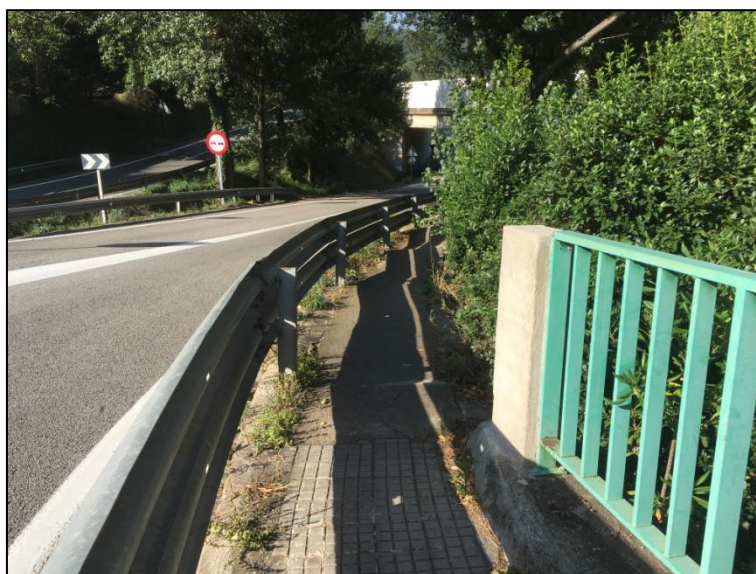
FOTO 4. Fi del paviment de panot i inici del paviment de formigó. A la dreta, barana de l'obra de drenatge transversal del torrent de la Font d'en Llanes
