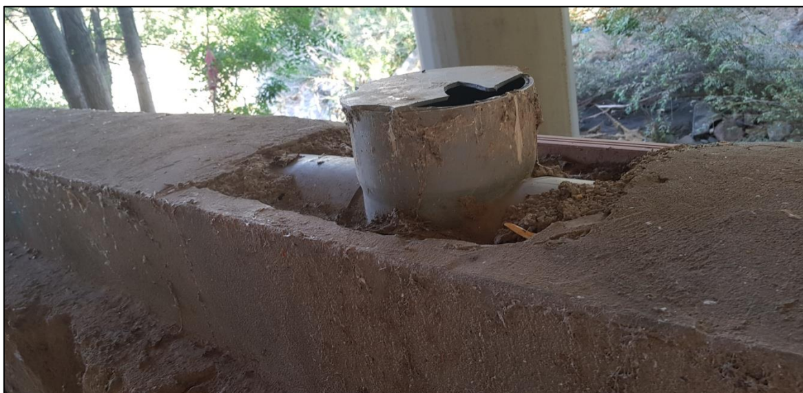
FOTO 18. Punt de registre de la canonada de clavegueram
