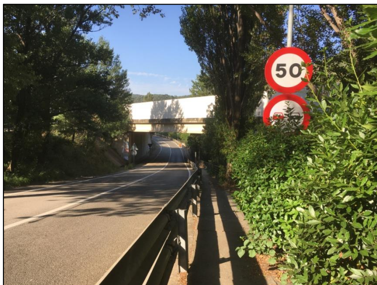
FOTO 7. Senyalització vertical, on es veu la limitació de velocitat a 50 km/h. Al fons, pas inferior de l'autovia C-17
