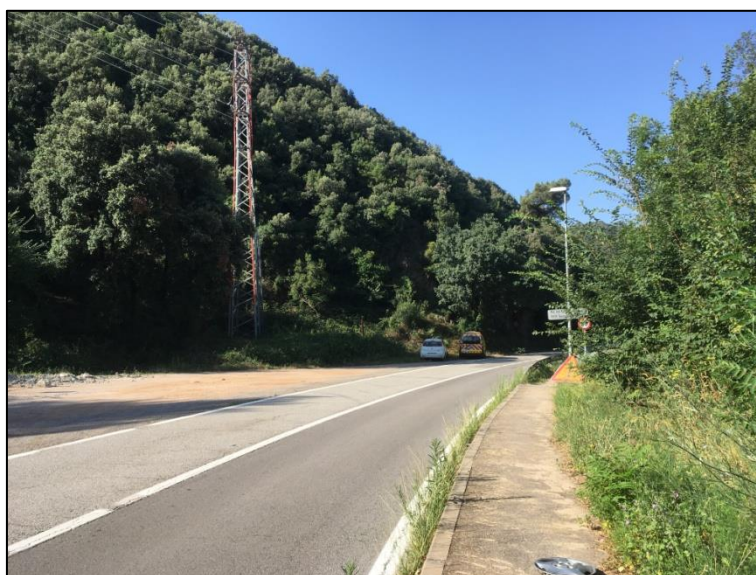
FOTO 61. Torre metàl·lica d'una línia elèctrica aèria de MT
