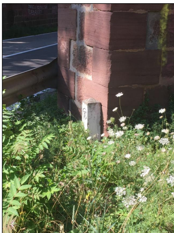
FOTO 50. Fita que indica el pas d'una línia soterrada de Telefónica
