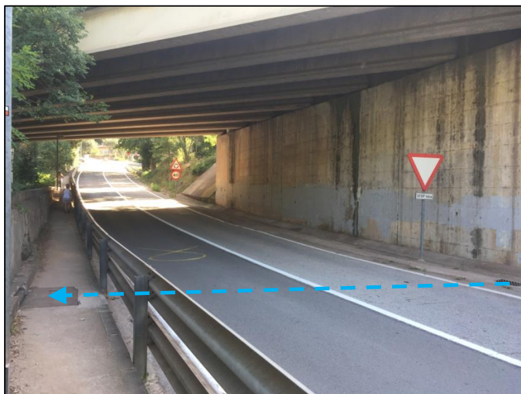
FOTO 22. Obra de drenatge transversal de la carretera N-152a
