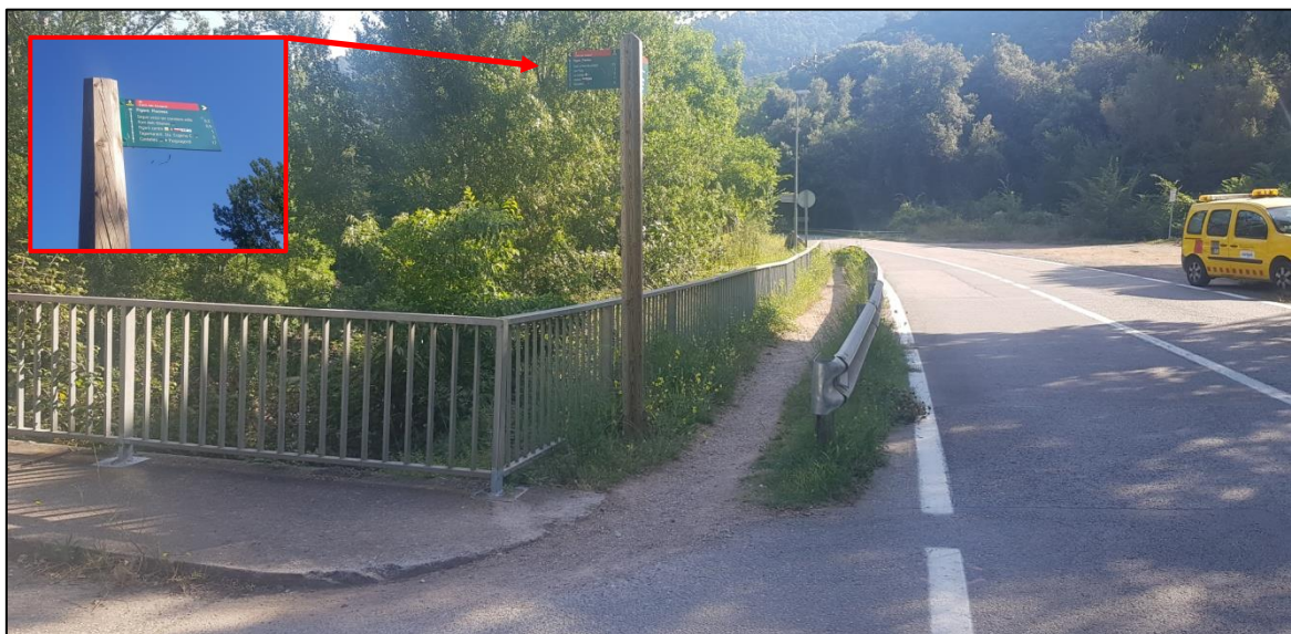
FOTOS 66a i 66b. Punt final de l'actuació amb senyalització d'orientació del camí fluvial del riu Congost, del qual forma part aquest carril bici i de vianants
