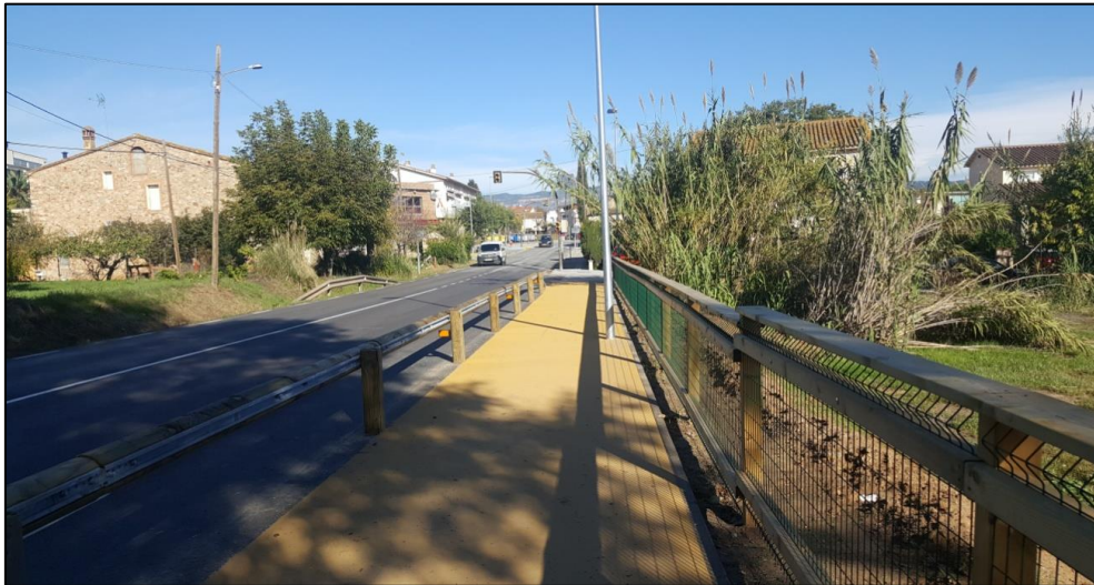
Figura 11. Tanca amb passamà de fusta de pi i reixa electrosoldada en un itinerari (model Tordera 1002 de Disseny Barraca)
