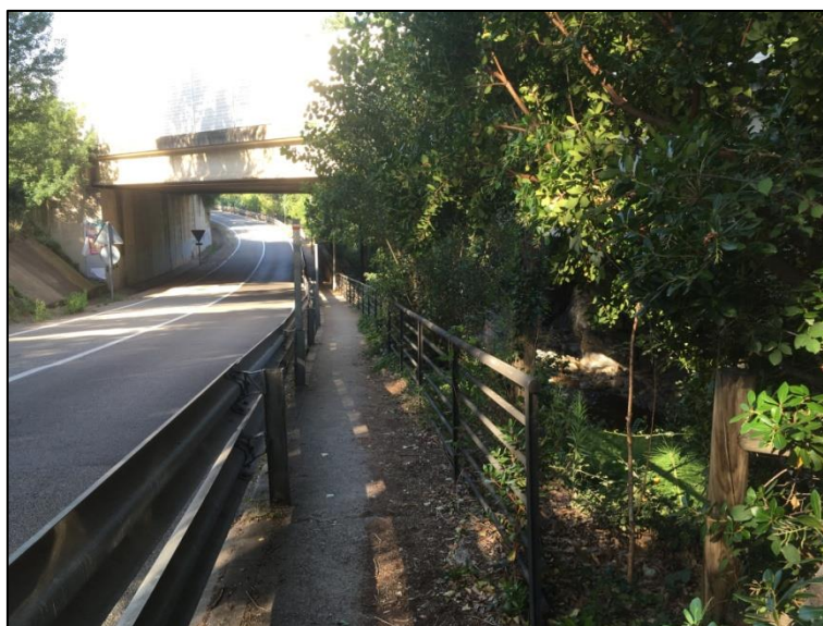
FOTO 12. Zona on la bionda passa d'estar instal·lada a dalt de la vorera a la calçada
