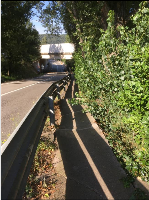
FOTOS 5a i 5b. Paviment de formigó en mal estat a la zona de la Font dels Gitanos
