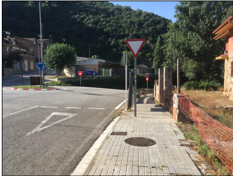
FOTO 1. Inici de l'actuació del carril bici i de vianants a la rotonda de la ctra. de Ribes. Tapes de registre de Telefónica i d'electricitat
