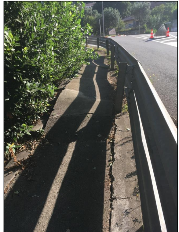
FOTOS 5a i 5b. Paviment de formigó en mal estat a la zona de la Font dels Gitanos
