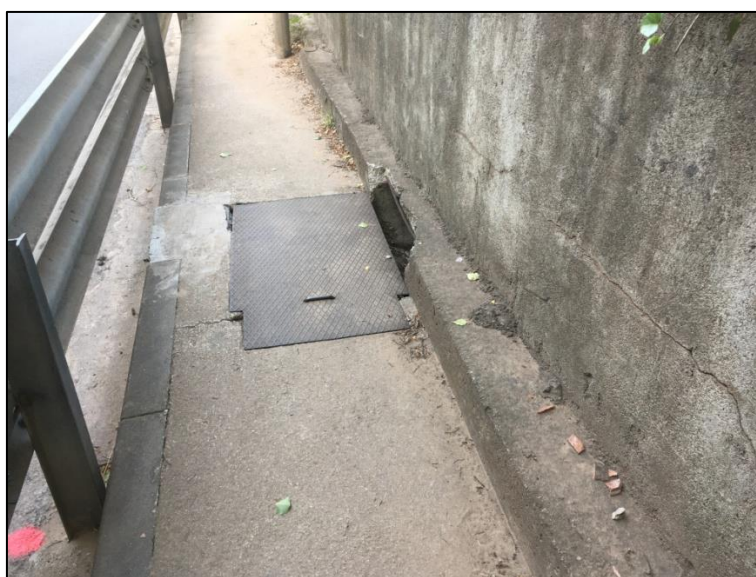
FOTO 21. Tapa de registre d'una obra de drenatge transversal de la carretera N-152a
