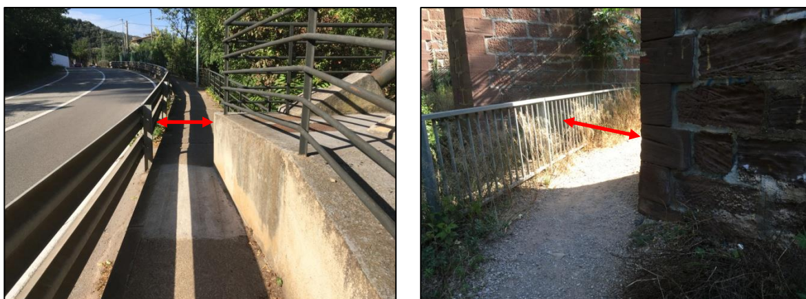
Figura 4. Punts on l'amplada de l'itinerari es redueix, als PK 0+158 i 0+370
