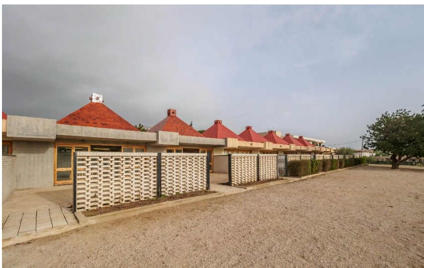
Fig. 3 – Vista exterior de les aules de l'antiga escola Àster
