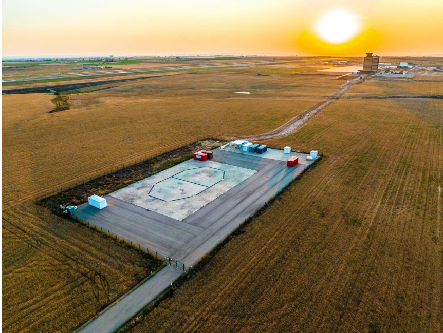
Figura 2. Plataforma de proves
