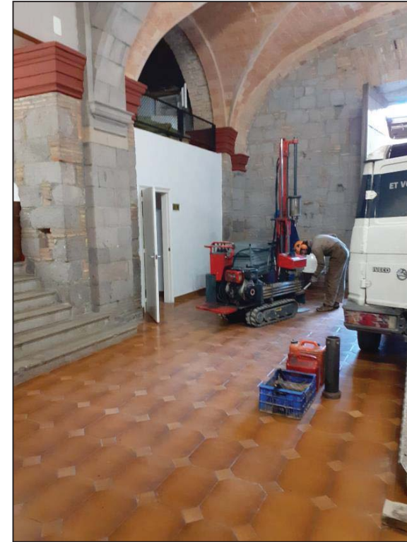
Foto 1. Execució Penetròmetre P-1.
