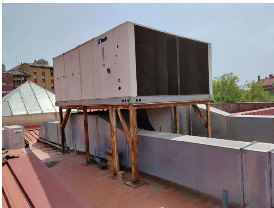
Planta refrigeradora actual. Roca YORK model: B2IH180A50 E1
