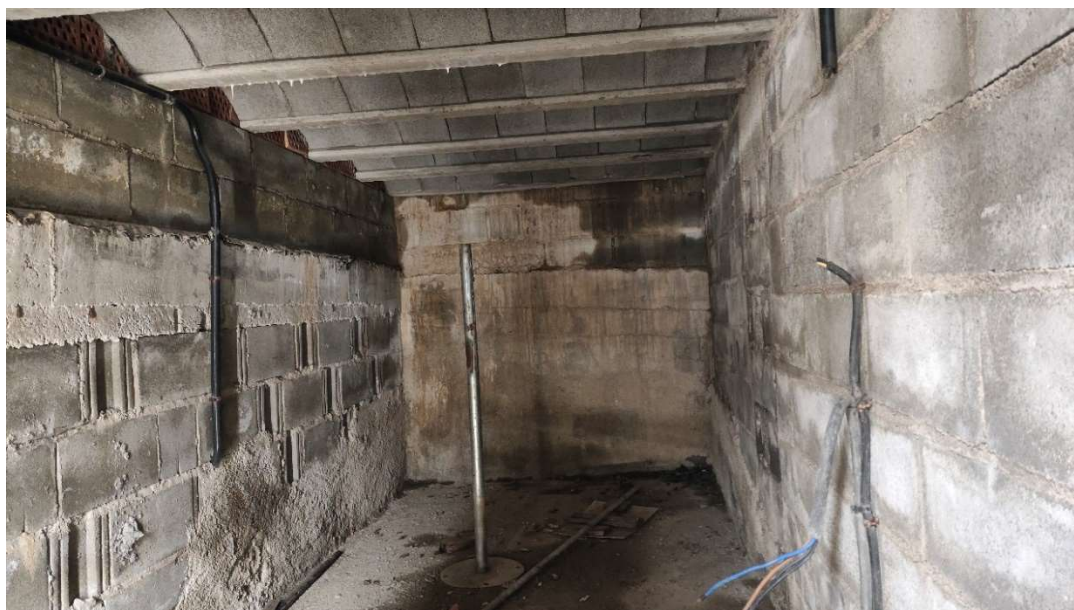
Fig. 26 Vista interior sala tècnica inversor (a condicionar).
