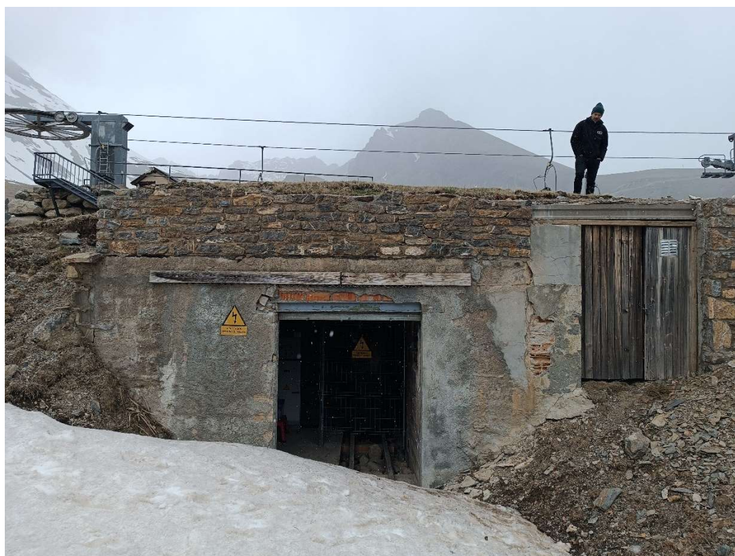
Fig. 25 Vista ubicació sala tècnica inversor (dreta) i centre de transformació (esquerra)
