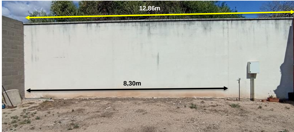
Foto nº 3. Vista frontal: espai total disponible (12,86m) i espai que ocupen els nous 40 nínxols en el cementiri del Vendrell (8,30m).
