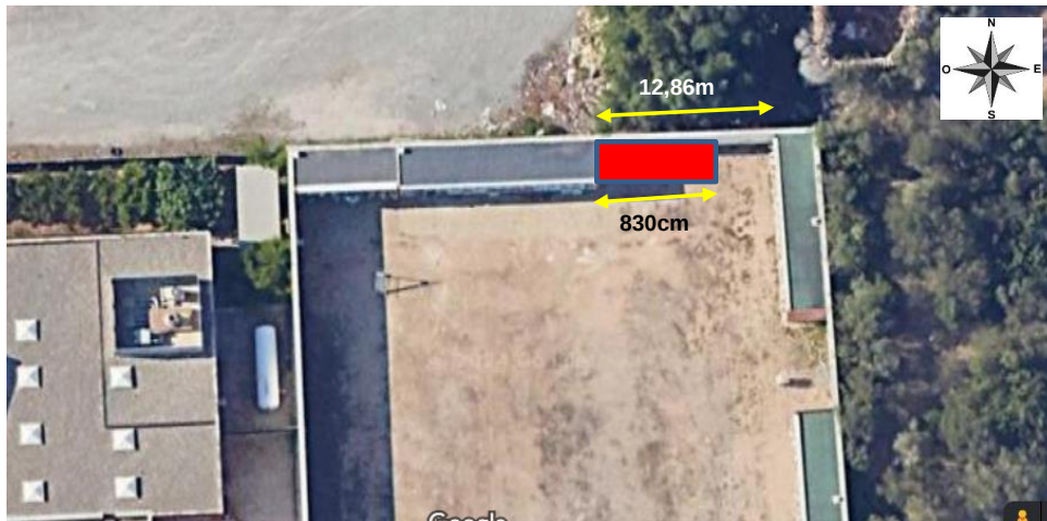
Foto nº 2. Vista aèria: espai total disponible i espai que ocupen els nous 40 nínxols en el cementiri del Vendrell.
