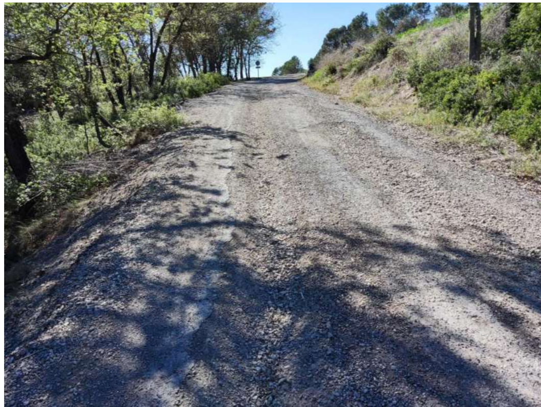
Figura 5. Enfonsament de la plataforma.
