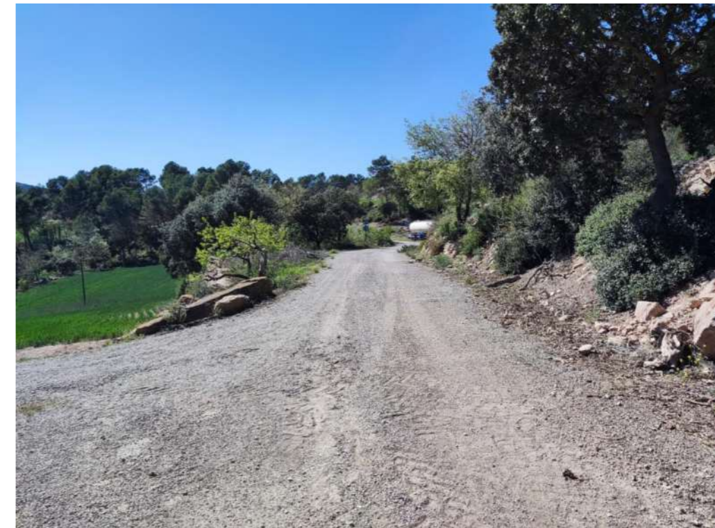
Figura 2. Tram previ al primer gual de formigó, amb grava i reg asfàltic.
