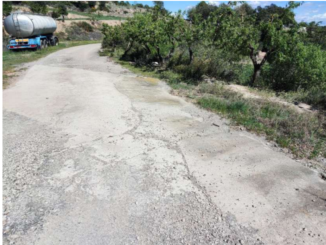
Figura 7. Gual de formigó al punt baix.
