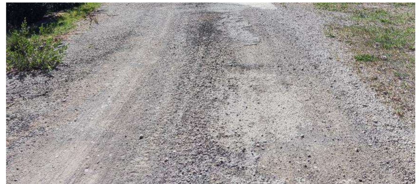
Figura 4. Estat general del camí de Cal Gironella
