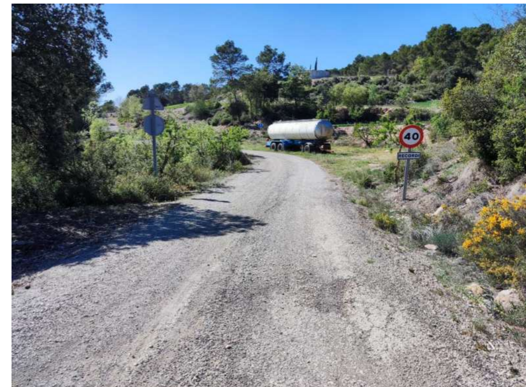
Figura 3. Detall del reg asfàltic, el qual es pot veure amb ruptura i esquerdes diverses.
