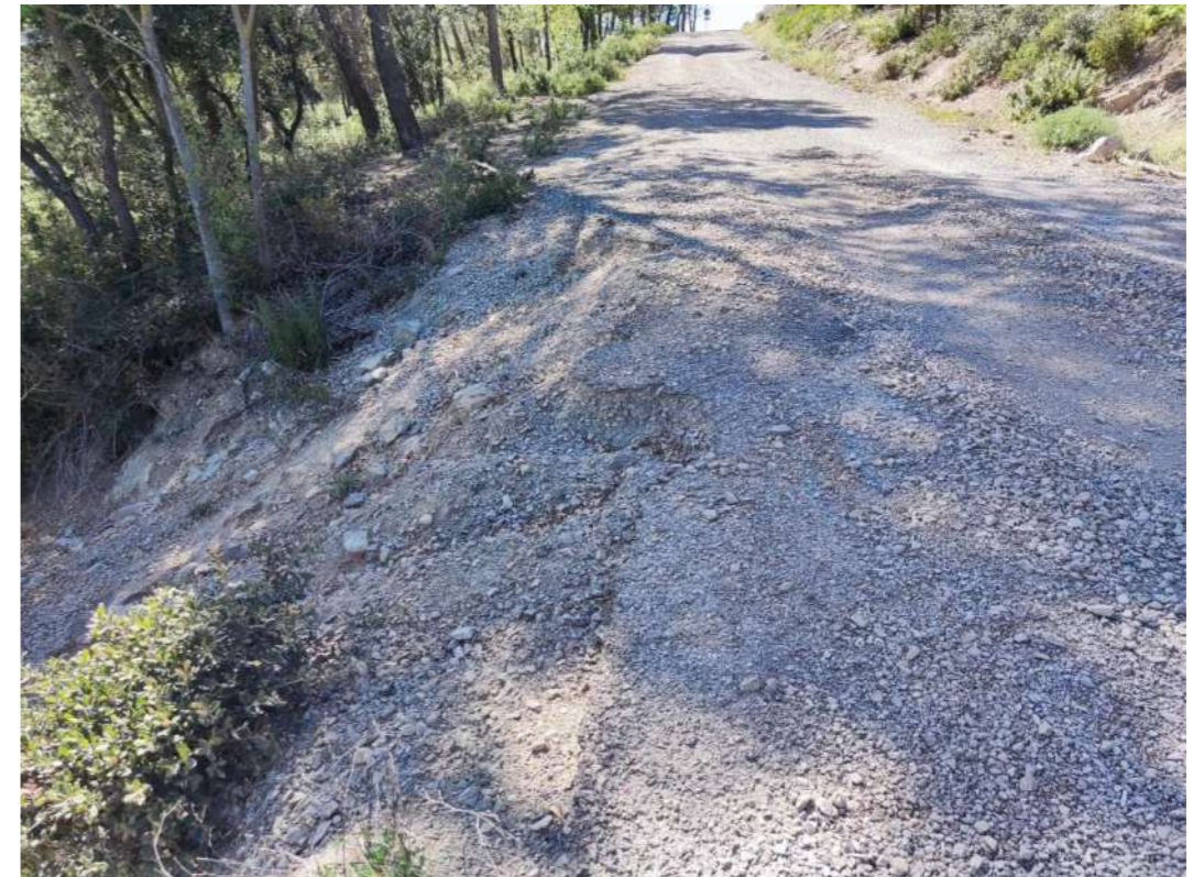
Figura 6. Erosió del punt baix.
