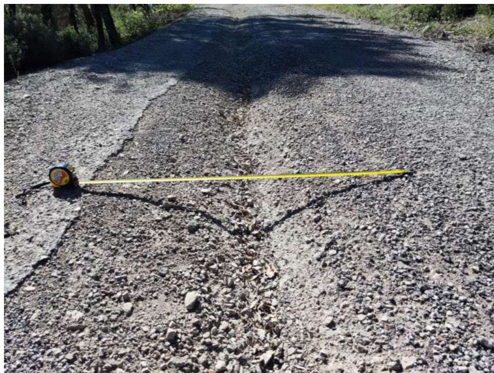
Figura 9. Detall de l'erosió, d'uns 10 cm de gruix.
