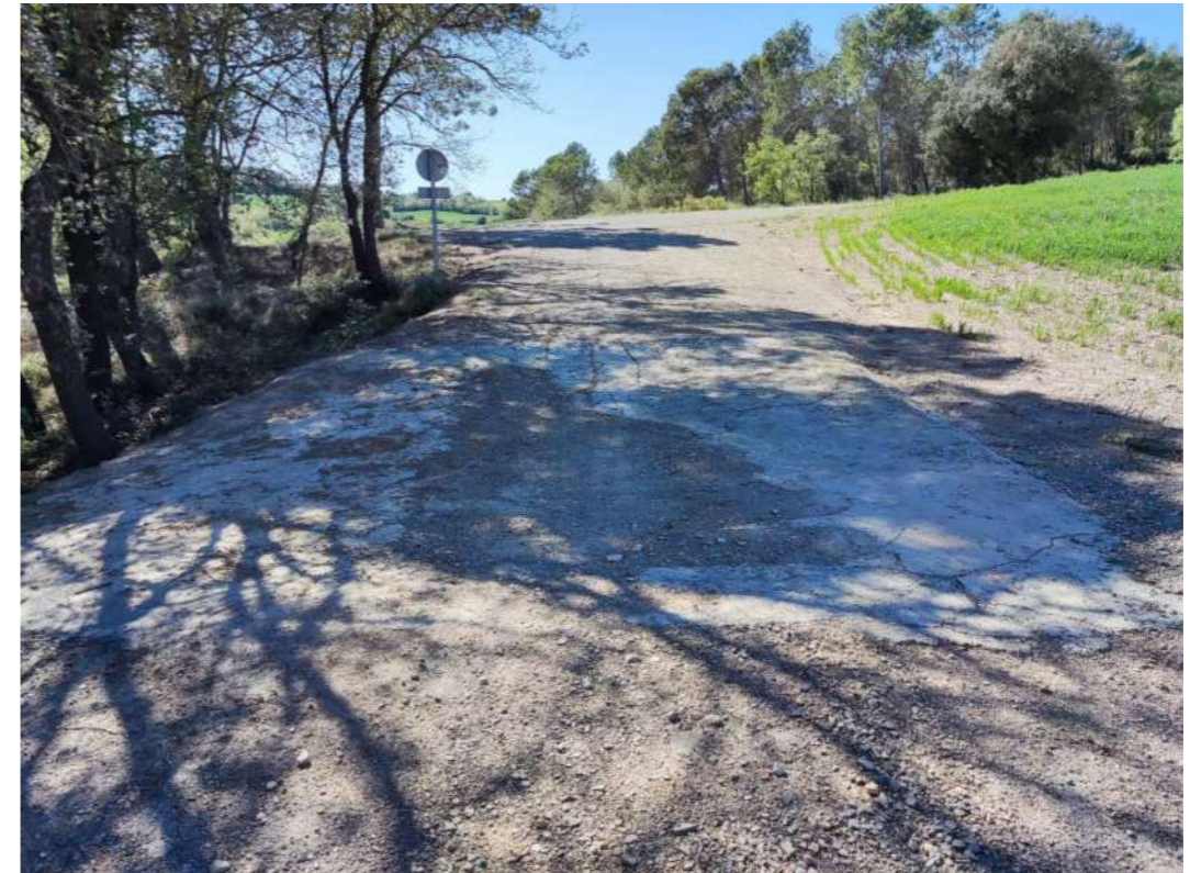
Figura 8. Gual de formigó al punt alt
