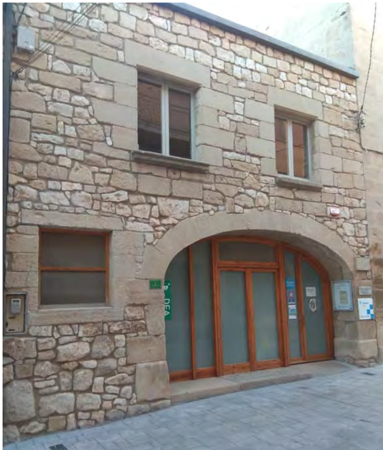
Façana principal (sud-oest) edifici que acull el consultori mèdic
