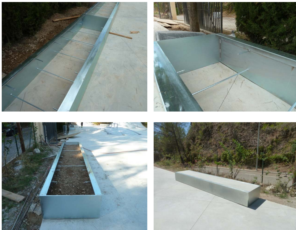
Soldadura llisa i continua entre l'angular i la vora dels obstacles "M". Connectors, Reomplert i Acabats.
