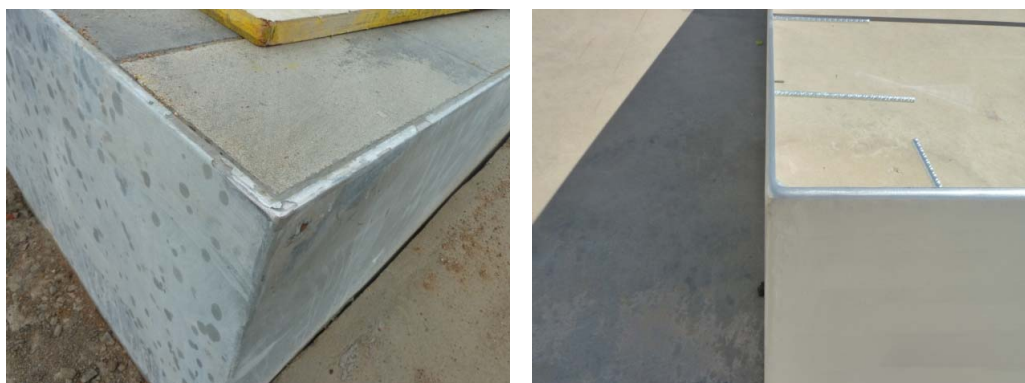
Arestes i cantonades "matejades" a taller, abans del galvanitzat, per evitar punxes o fils que tallin.
