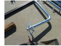
Detall Tipus d'Ancoratges de Rail
