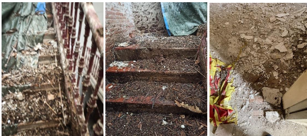
Imatges de l'estat de conservació general. Fotos: GAA.SLP 31/03/2023
