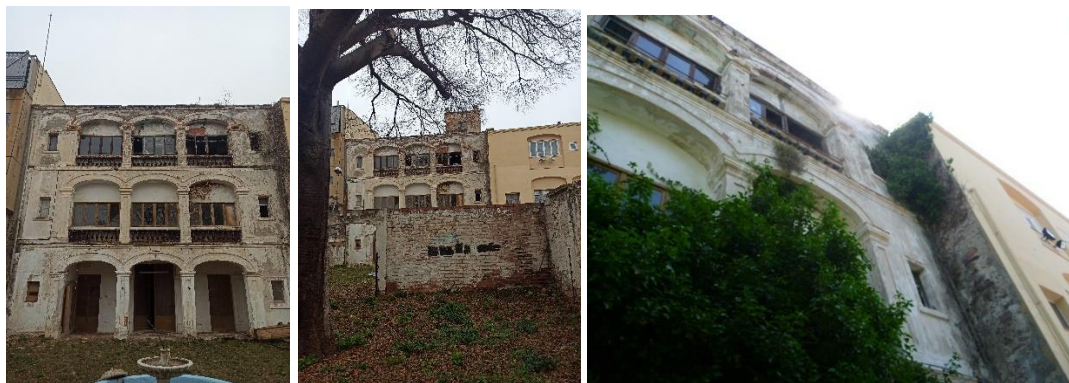
Imatges de la façana enjardinada orientada a l'oest. Foto: 31/03/2023
