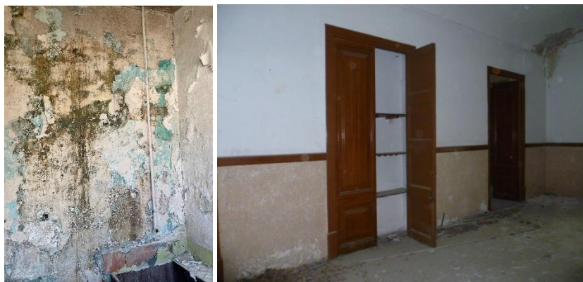
Imatges de murs de l'edifici. Fotos: 04/06/2019.
