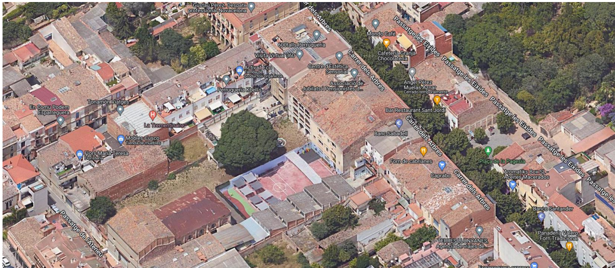
La coberta i edifici vist des de l'angle sud-est. Edifici i entorn urbà. Font: googlemaps.com
