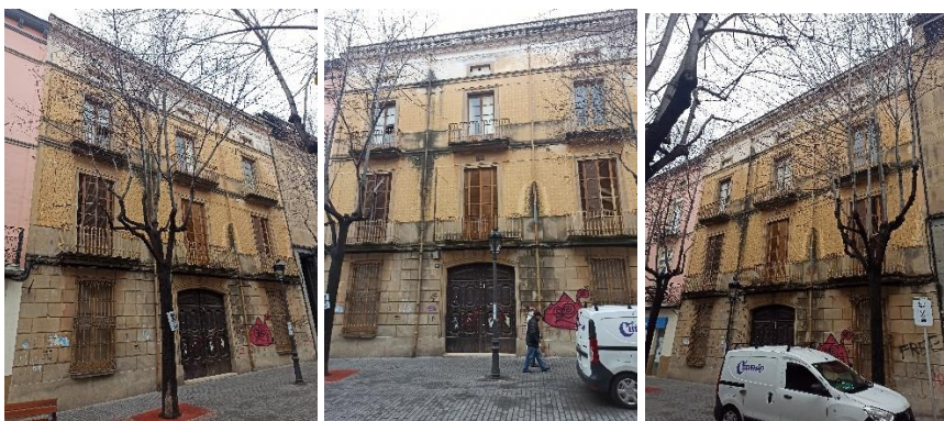
Imatges de la façana principal orientada a l'est. Foto: 27/02/2023
