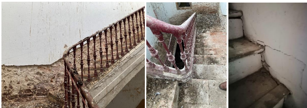
Imatges de les escales interiors entre les diferents plantes de l'edifici. Fotos: 31/03/2023
