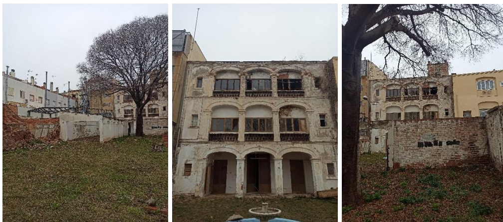
Imatges de l'àmbit oest d'accés a l'edifici. Font: GAA.SLP 13/07/2017
