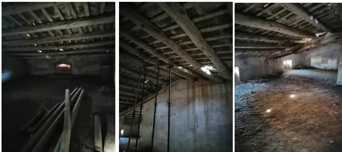
Imatges de l'estructura de suport de la coberta. Planta sota-coberta. Nivell +13,25mts. Foto: 13/03/2023.
