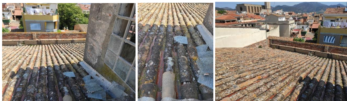
Imatges generals de la coberta. Fotos: 07/05/2021.
