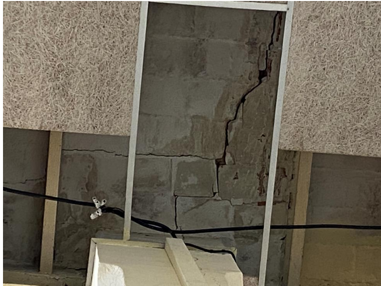
Il·lustració 16. - esquerda en solera ceràmica de coberta
