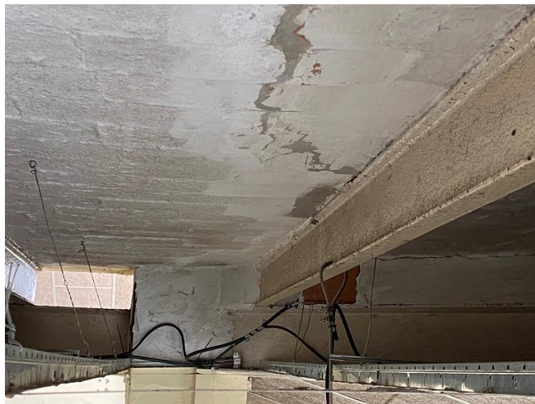
Il·lustració 4.- bigueta i solera ceràmica
