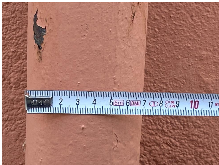
Il·lustració 26.- dimensions del baixant exterior
