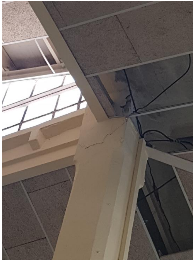
Il·lustració 19.- esquerra en cap de pilar de formigó
