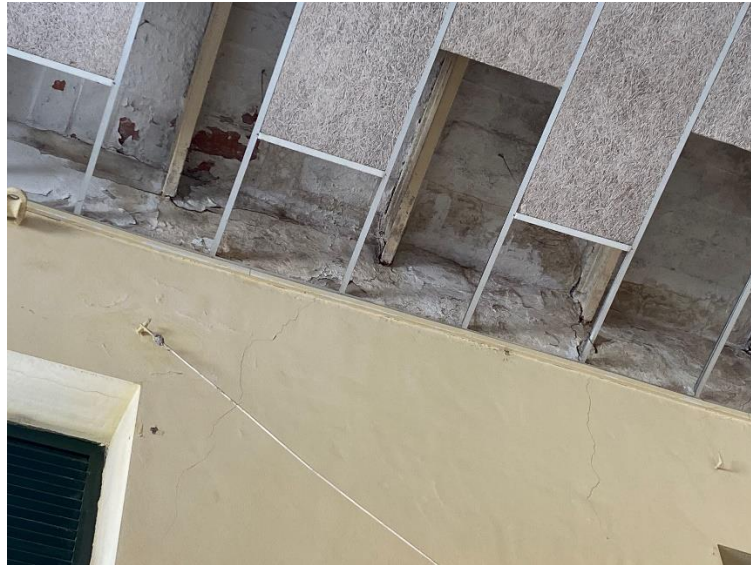
Il·lustració 13.- vista de diferents recolzaments de biguetes
