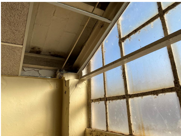
Il·lustració 21.- vista de les humitats en la solera ceràmica
