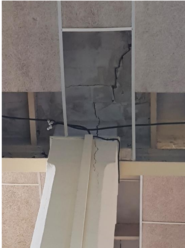
Il·lustració 18.- esquerra en pilar central de formigó
