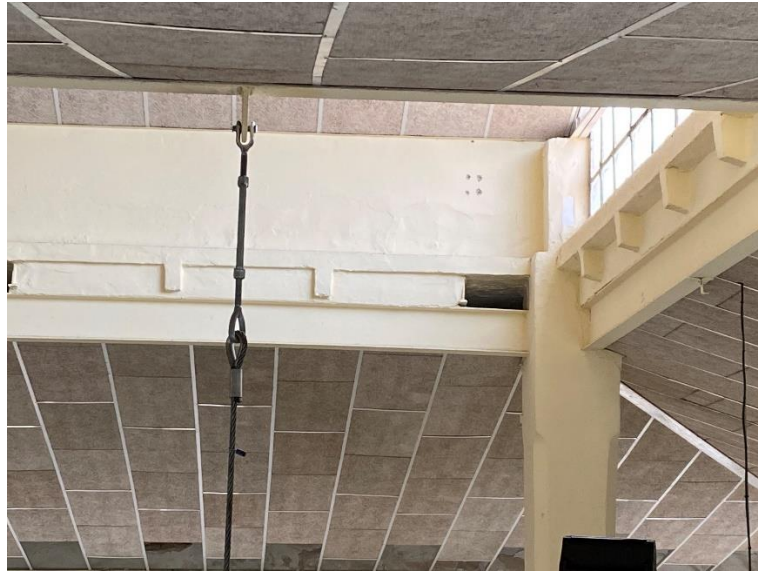
Il·lustració 5. - Jàsseres metàl·liques i pilar de formigó
