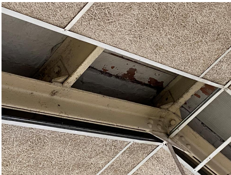
Il·lustració 7.- Cordó superior de l'encavallada
