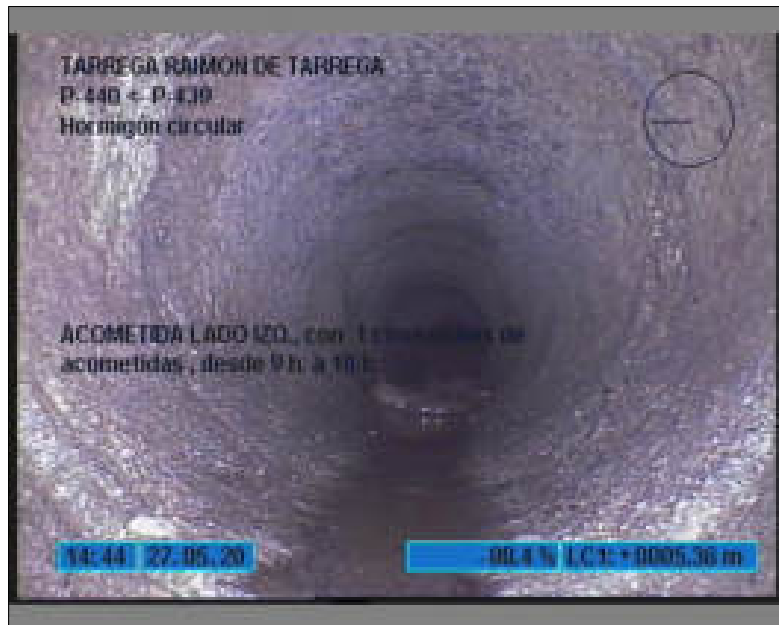
Foto: 9_9_54_A.JPG 5,3m, ACOMETIDA LADO IZQ., con 1 conexiones de acometidas , desde 9 h. a 10 h.
