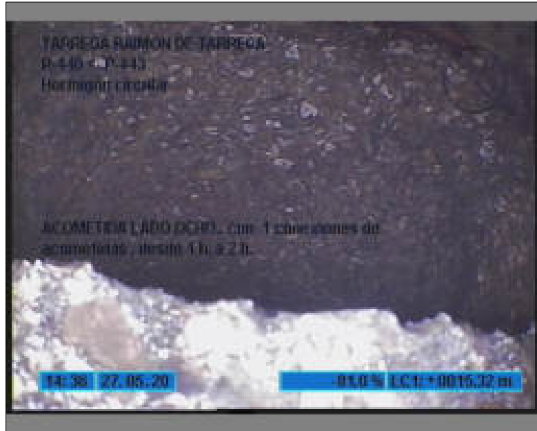
Foto: 8_8_51_A.JPG 15,3m, ACOMETIDA LADO DCHO., con 1 conexiones de acometidas , desde 1 h. a 2 h.
