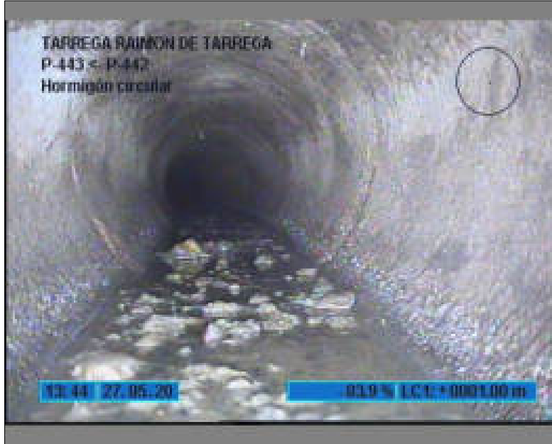
Foto: 7_7_41_A.JPG 1m, INICIO DE LA INSPECCION, INICIO DE LA TUBERIA
