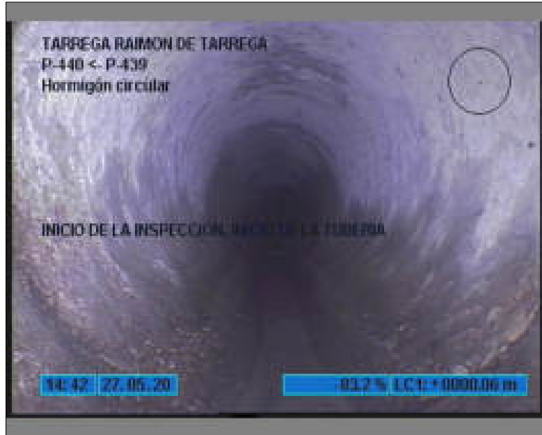
Foto: 9_9_53_A.JPG 0,6m, INICIO DE LA INSPECCION, INICIO DE LA TUBERIA
