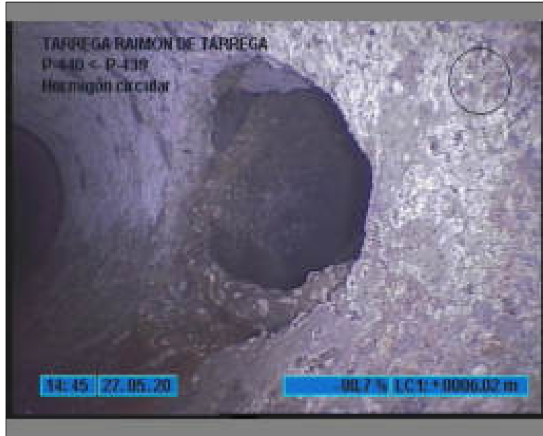
Foto: 9_9_55_B.JPG 6m, ACOMETIDA LADO DCHO., con 1 conexiones de acometidas , desde 1 h. a 2 h.
