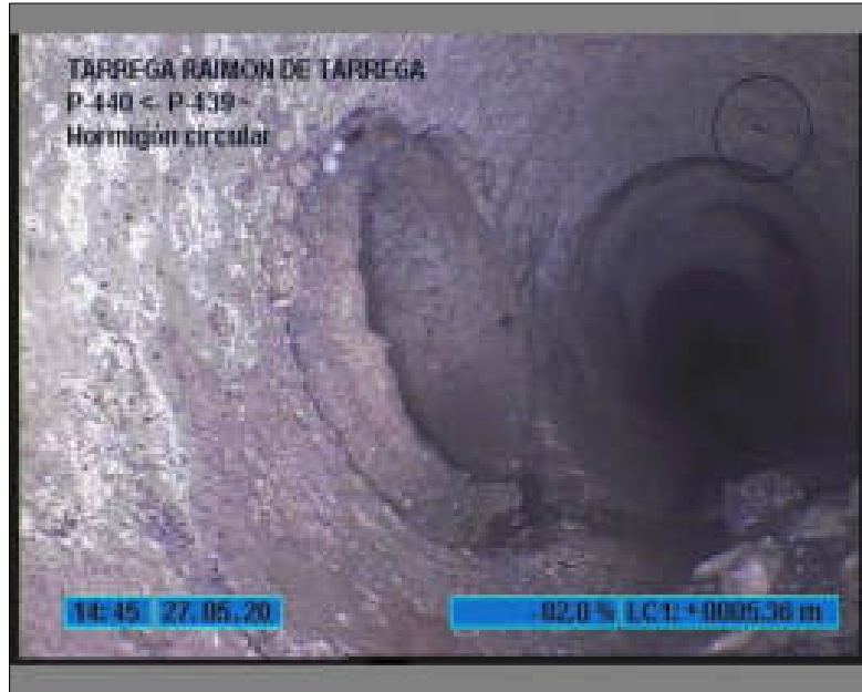
Foto: 9_9_54_B.JPG 5,3m, ACOMETIDA LADO IZQ., con 1 conexiones de acometidas , desde 9 h. a 10 h.
