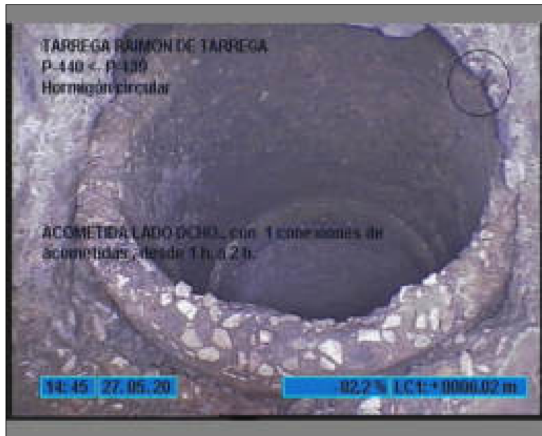
Foto: 9_9_55_A.JPG 6m, ACOMETIDA LADO DCHO., con 1 conexiones de acometidas , desde 1 h. a 2 h.
