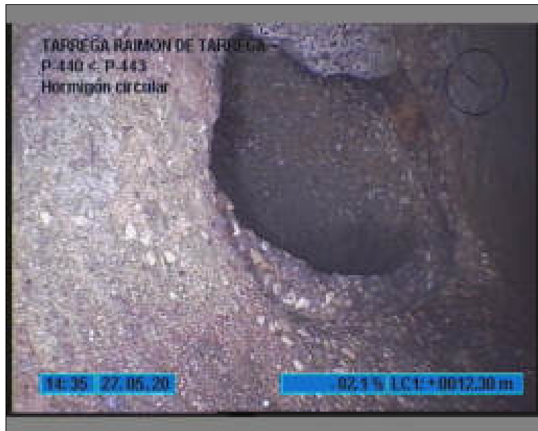
Foto: 8_8_50_B.JPG 12,3m, ACOMETIDA LADO IZQ., con 1 conexiones de acometidas , a 10 h.
