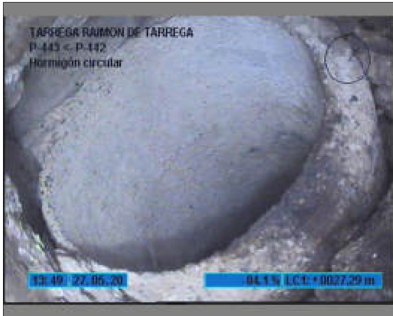
Foto: 7_7_45_A.JPG 27,2m, ACOMETIDA LADO DCHO., con 1 conexiones de acometidas , a 1 h.
