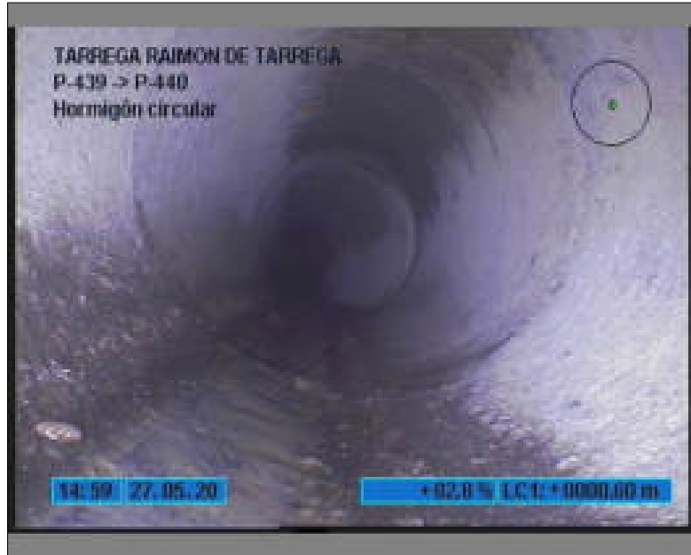
Foto: 10_10_59_A.JPG 0,6m, INICIO DE LA INSPECCION, INICIO DE LA TUBERIA
