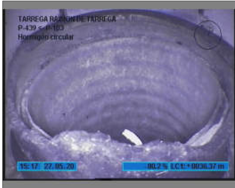
Foto: 11_11_69_A.JPG 36,3m, ACOMETIDA LADO DCHO., con 1 conexiones de acometidas , a 1 h.
