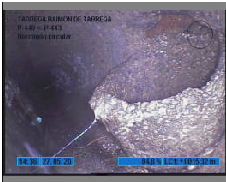
Foto: 8_8_51_B.JPG 15,3m, ACOMETIDA LADO DCHO., con 1 conexiones de acometidas , desde 1 h. a 2 h.
