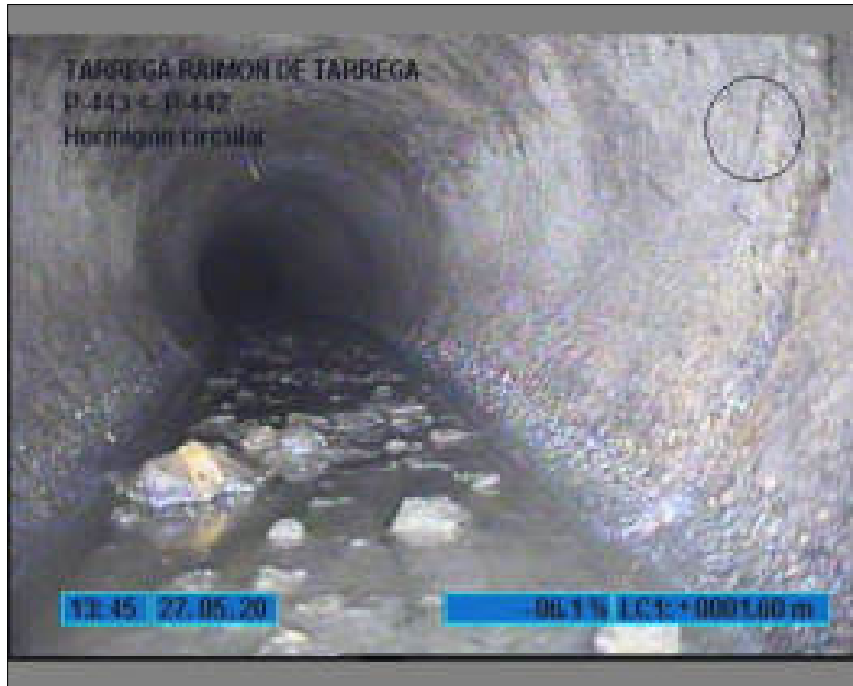
Foto: 7_7_42_A.JPG 1,6m, SEDIMENTACION DE , ACUMULACION DE GRAVA
