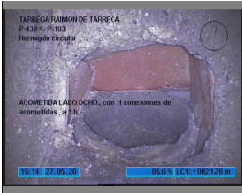
Foto: 11_11_67_A.JPG 21,2m, ACOMETIDA LADO DCHO., con 1 conexiones de acometidas , a 1 h.
