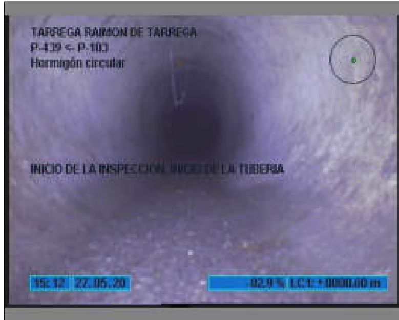
Foto: 11_11_65_A.JPG 0,6m, INICIO DE LA INSPECCION, INICIO DE LA TUBERIA
