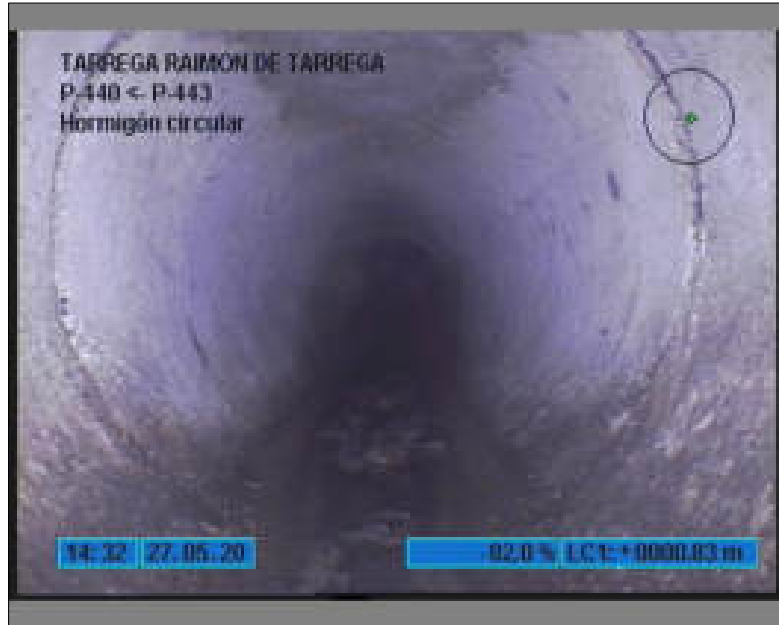
Foto: 8_8_48_A.JPG 0,6m, INICIO DE LA INSPECCION, INICIO DE LA TUBERIA
