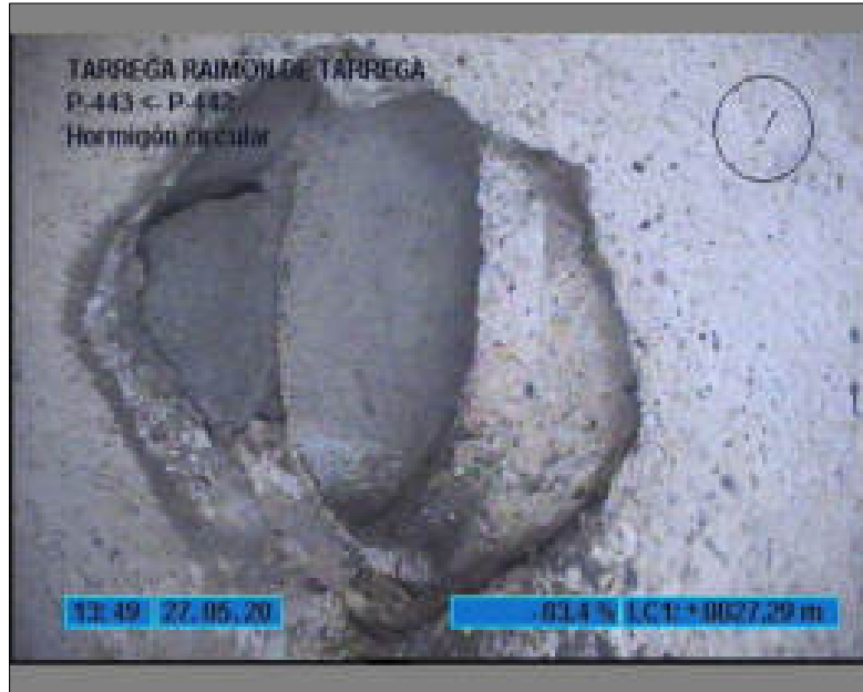
Foto: 7_7_45_B.JPG 27,2m, ACOMETIDA LADO DCHO., con 1 conexiones de acometidas , a 1 h.
