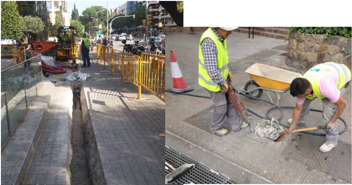
Exemples Canalització Convencional en àmbit municipal.
