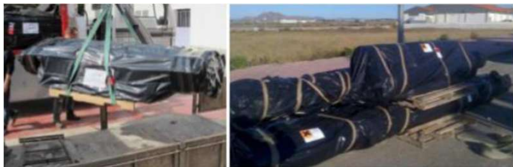
Figura 3: Exemple emmagatzematge temporal de tubs de fibrociment
