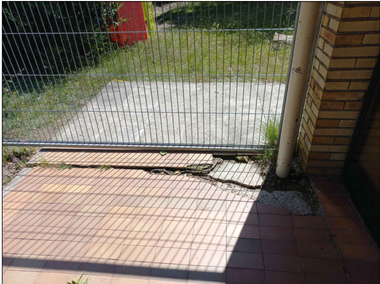
REPARAR PAVIMENT EXTERIOR:
