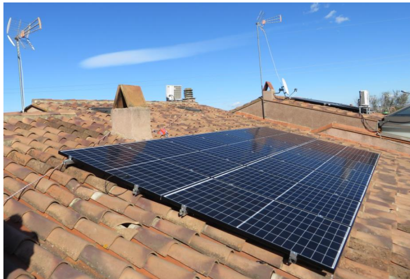
Instal·lació coplanar a coberta de teula
