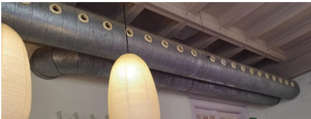
Fotografia 19. Conductes ventilació planta semi sotterrani.
