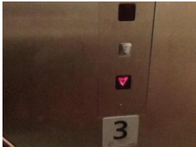
Fig. 60 Botonera exterior. Amb relleu i Braille.
