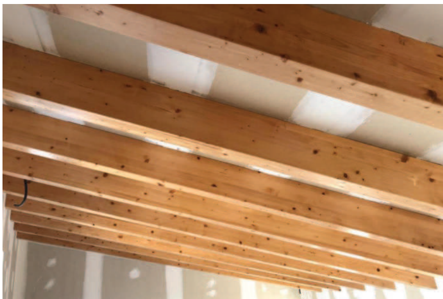
Fotografia 6. Bigues amb aplicació de vernissos intumescents.
