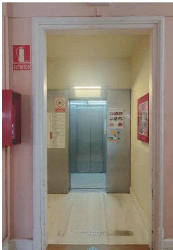
Fotografia 14. Accés sector escala, es planifica posar porta al costat de l'ascensor en obertura en sentit contrari al d'evacuació, però amb sistema de tancament per electró imants connectat amb central contra incendis.
