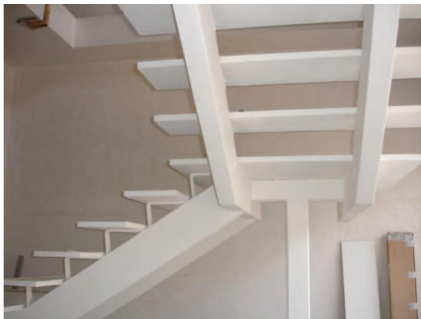
Fotografia 7. Exemple escala de fusta pintada amb pintura intumescent.
