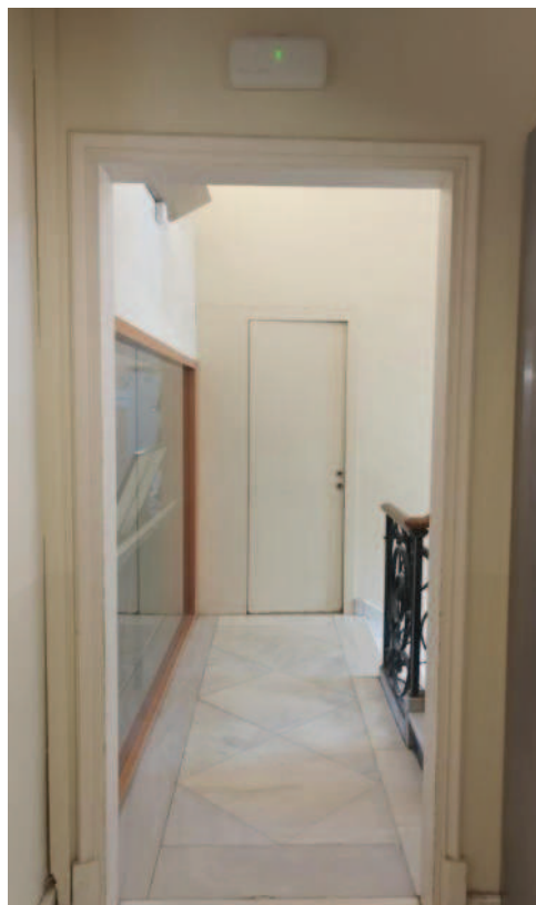
Fotografia 14. Accés sector escala, es planifica posar porta al costat de l'ascensor en obertura en sentit contrari al d'evacuació, però amb sistema de tancament per electró imants connectat amb central contra incendis.
