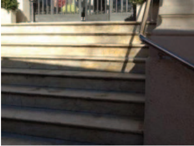
Fig. 50 i 51 Vista general escala accés principal.
