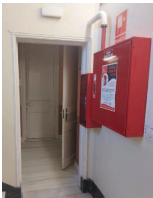
Fotografia 25. Porta per afegir, de fusta, amb motlures definides i tractament ignífug. Desplaçament de la BIE i l'extintor.
