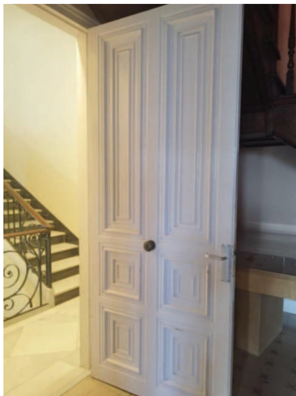
Fotografia 24. Porta noble principal planta segona. Aplicar tractament ignífug fins a RF-60, ferratges i cinta perimetral.
