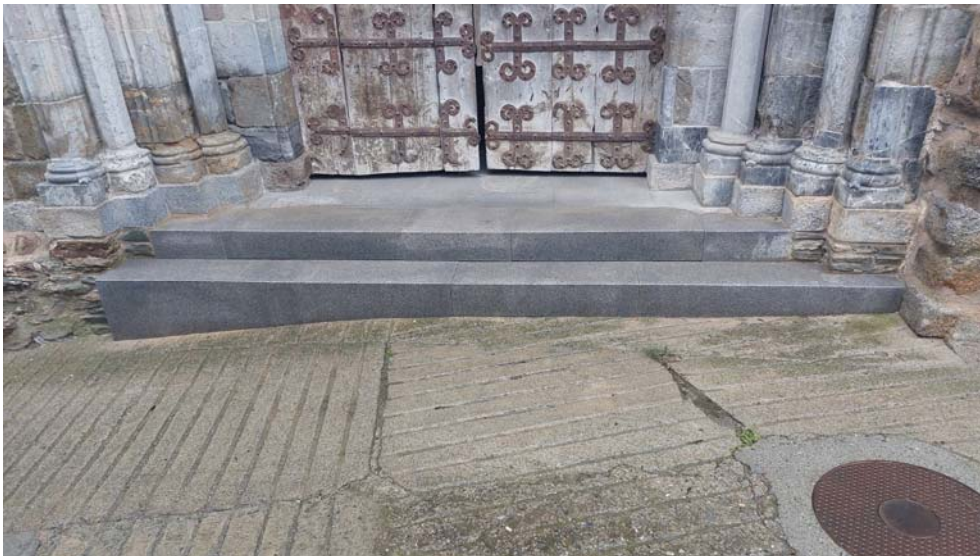
Imatge 6 - Rasants davant les escales de l'església a regularitzar durant la intervenció Alçada lateral dret:15cm; alçada centre:22cm; alçada lateral esquerre: 40cm
