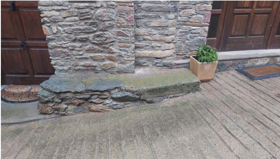
Imatge 5 - Banc entre Cal Feliu i Cal bru- meitat pedra, meitat formigó
